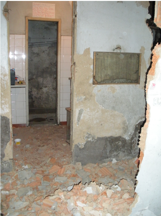
Foto 15 Prédio em obras Galiza, H. 2008
