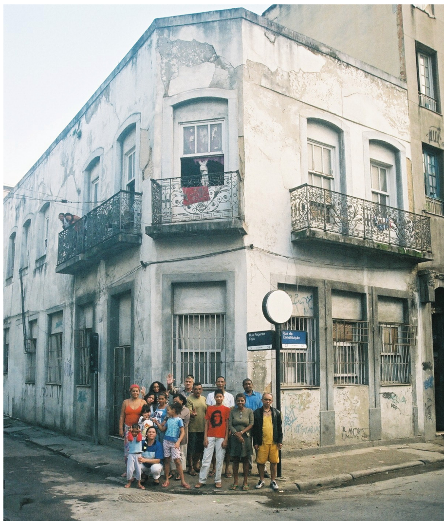
Foto 1 Alguns moradores em frente ao prédio Fonte: Duncan Crossley, 2008
