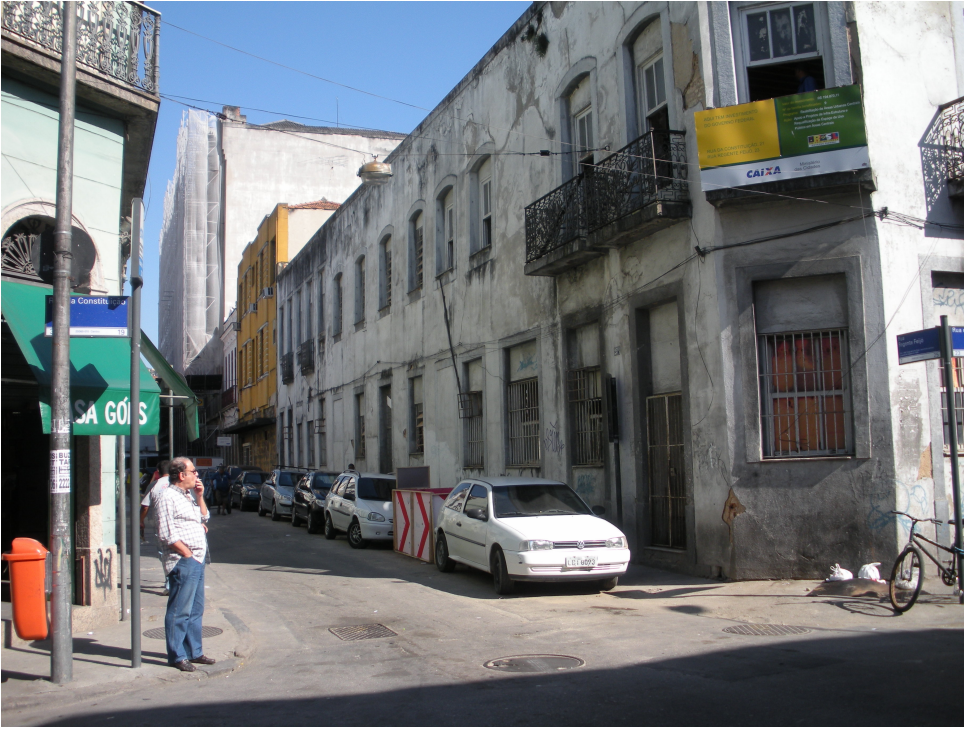
Foto 14 Prédio em obras H.Galiza, 2008
