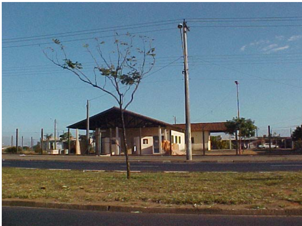
F 31 – Unidade de Serviço Social
