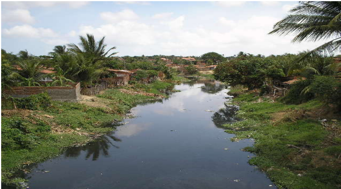
Figura 12 – Vista dos imóveis expostos à área de risco para inundações em um dos bairros da SER V ao longo do Rio Maranguapinho em Fortaleza.
