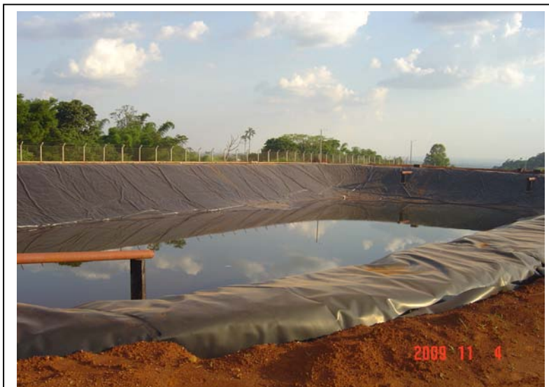
Figura 18: Imagem da primeira lagoa de tratamento da ETE em pleno avanço de construção. Foto: Autor (2009).
