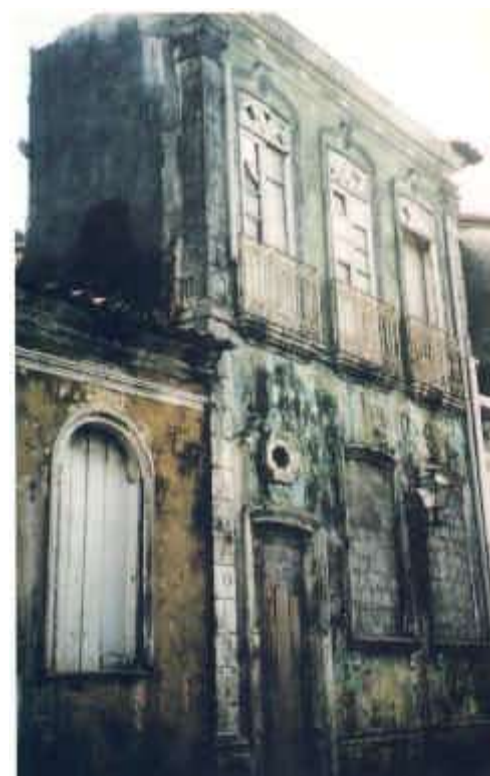
117-118. Estado de conservação de edificações anterior às intervenções
