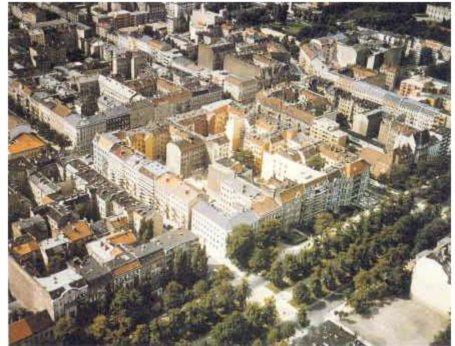
107. A área de Klausenerplatz após as obras de reabilitação, 1980
