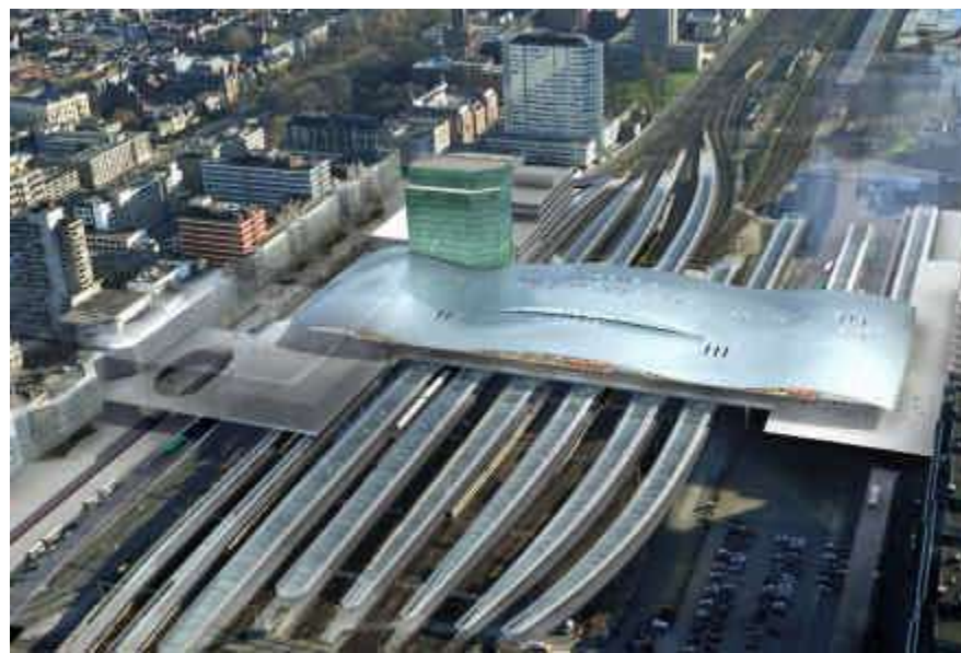
10-11. ... e o projeto de renovação e integração intermodal
