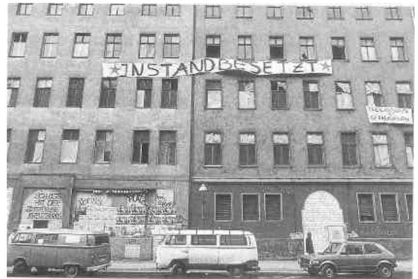
110-111. Demolições e resistência em Kreuzberg, década de 1970
