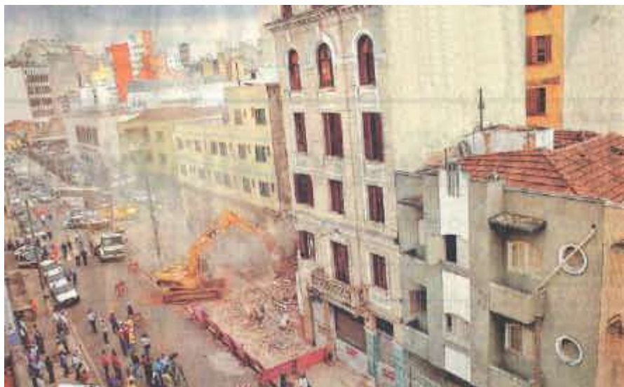
191. 26 de outubro de 2007: início das demolições na Luz ao centro, o edifício tombado que permanece
