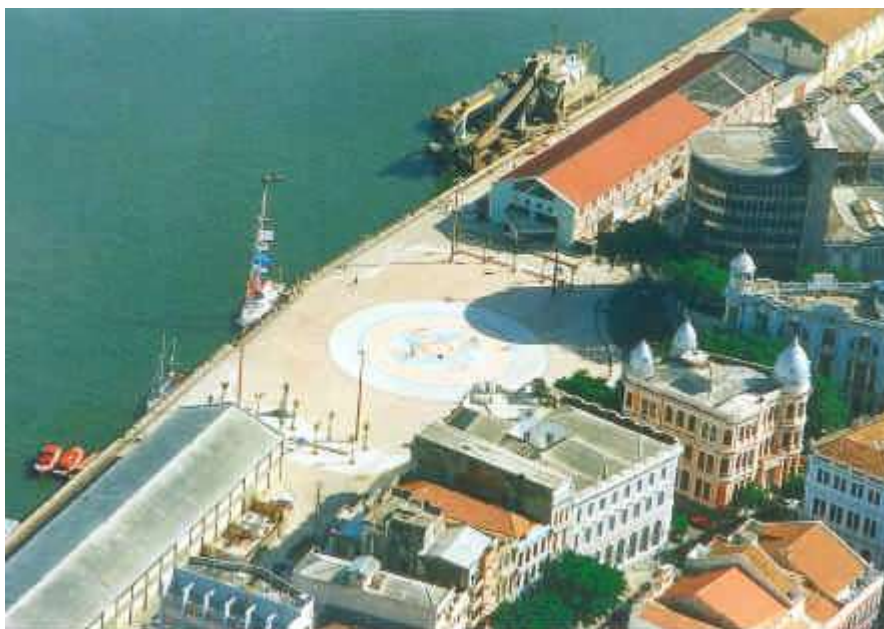
121-122. Recuperação de estruturas portuárias, junto à Praça Rio Branco
