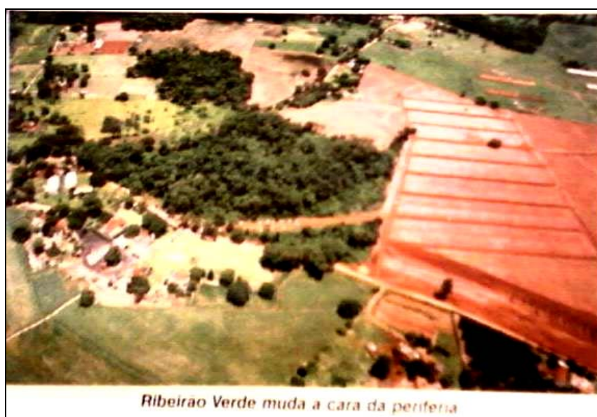
Figura 10 – Fotografia do empreendimento em fase adiantada de execução das obras, veiculada no Jornal da Cohab-RP , em abril de 2006, com a legenda “Ribeirão Verde muda a cara da periferia”.
