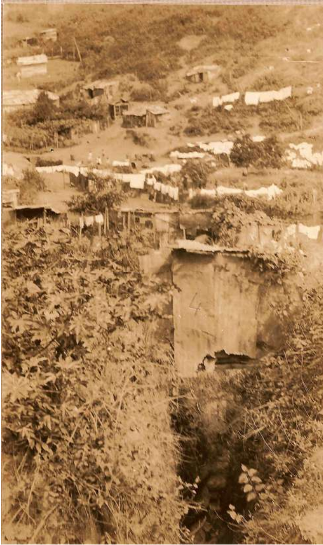
Figura 84 – Em primeiro plano, latrina na Saracura Grande abrindo-se sobre um rego d’água, denunciando a inexistência de esgoto na região. Logo acima, varais com roupa lavada e algumas casinhas construídas nas encostas, que novamente nos remetem a um cenário rural. Foto: Geraldo Horácio de Paula Souza. S/data. Fonte: Centro de Memória da Saúde Pública/Faculdade de Saúde Pública/USP.
