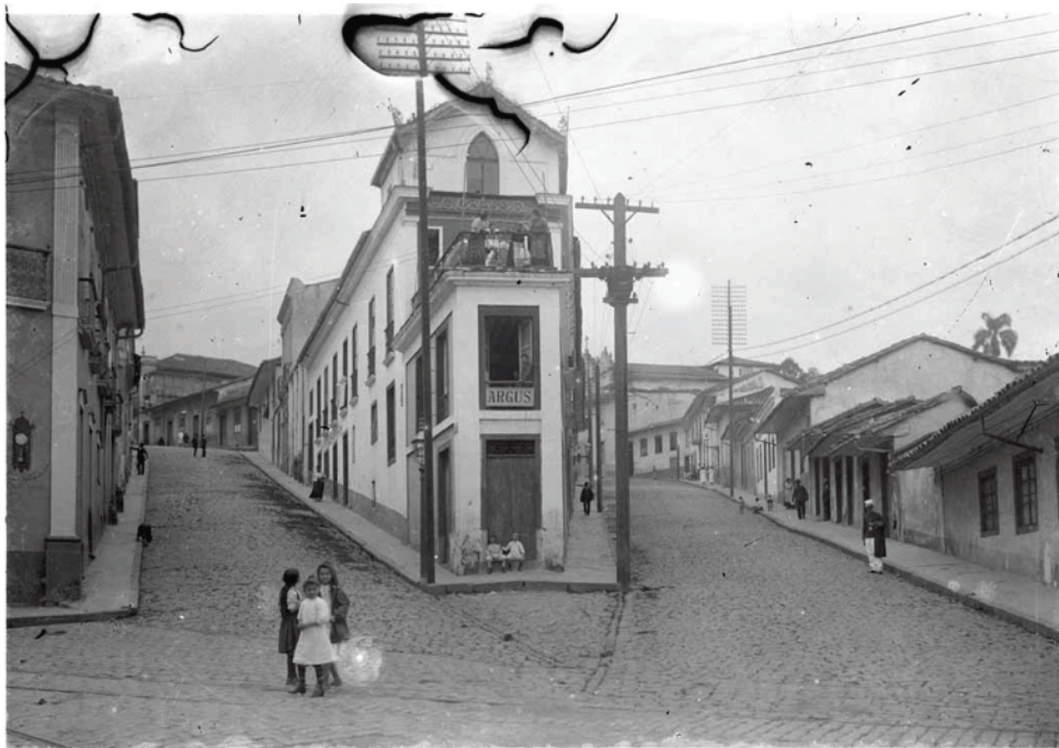
Figura 27 – Conforme as referências de Eudes Campos, o prédio construído entre 1886 e 1887, e demolido no final da década de 1950, pertenceu a Paschoal Gazíneo. Localizava-se no canto das antigas Ladeiras do Ouvidor e São Francisco. Autoria desconhecida, 1900-1910. Fonte: Coleção SAN/DIM/DPH/SMC/PMSP.
