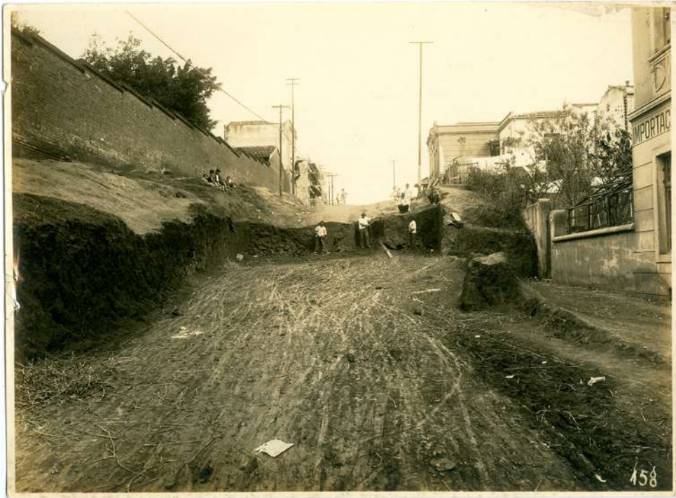
Figura 63 – Nos requerimentos das Obras Particulares nós frequentemente encontramos referências ao nivelamento das ruas junto às soleiras das casas. Este caso, na rua 13 de Maio, demonstra um momento em que o leito da rua está sendo nivelado, para o futuro calçamento. Observe-se a diferença entre o leito original, ainda a ser escavado, e aquele já trabalhado. Foto: 30/07/1921. Autoria desconhecida. Fonte: AHMWL.
