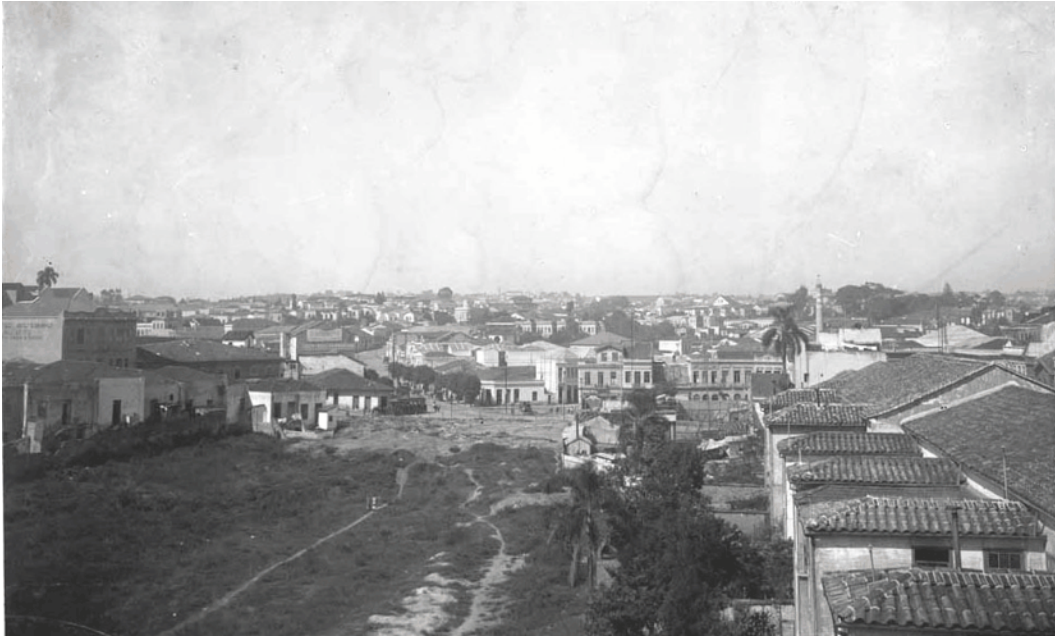
Figura 54 – Desta imagem, tomada do alto do antigo Viaduto do Chá, temos em primeiro plano, o vale do Anhangabaú, e os fundos do casario da rua Formosa. A fotografia, realizada em 1911, permite a visualização, ao fundo, do bairro do Bexiga. Aqui, percebemos um espaço de ocupação bastante densa, demonstrando que a configuração do bairro já era fato concreto. Foto: Aurélio Becherini. Fonte: Coleção SAN/SIM/DPH/SMC/PMSP.
