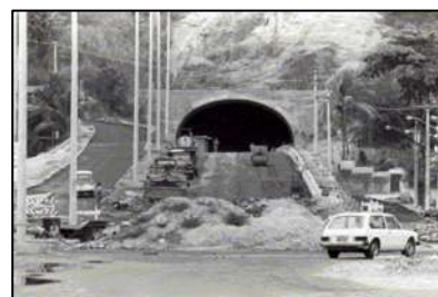
Fig. 25: Tunel Roberto Silveira, orla marítima de S. Francisco, Niterói, Fonte: www.urbanismo.niterói.rj.gob.br/ , Acesso: junho / 2008
