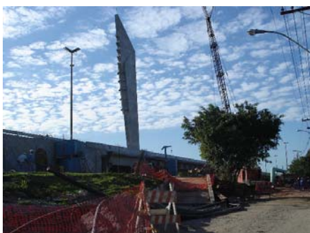
Foto da obra da ponte Arquivo pessoal, 2008
