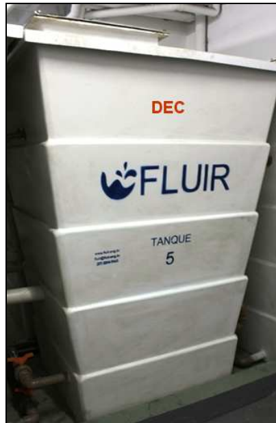
Figura 21: Decantador
