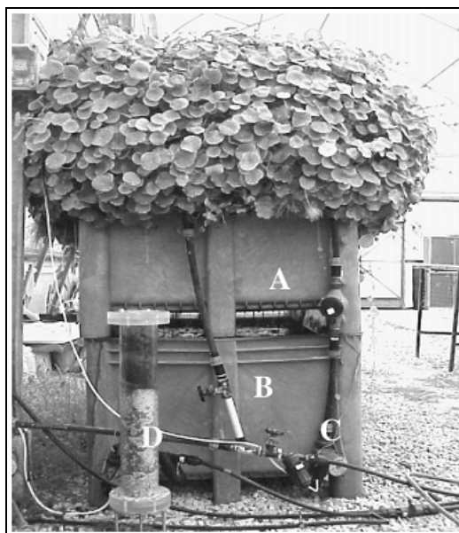
Figura 8: Foto da wetland construída de fluxo vertical recirculada (RVFCW). (A) wetland de fluxo vertical, (B) reservatório, (C) bomba de recirculação e (D) filtros de camada (constituídos de turfa, calcário, pedras e cal)
