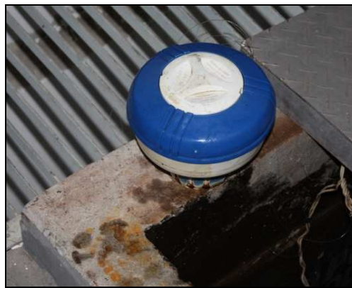
Figura 26: Clorador de pastilhas
