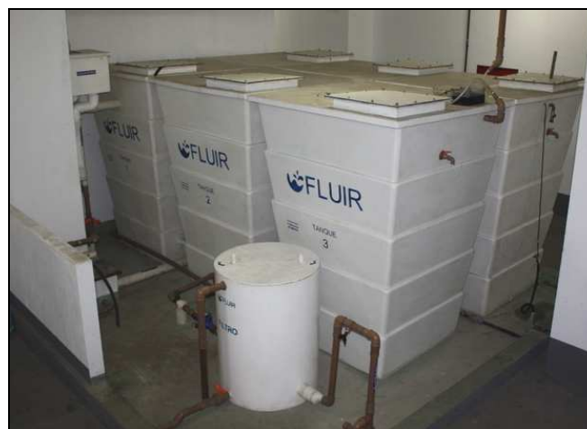
Figura 15: Vista da ETAC
