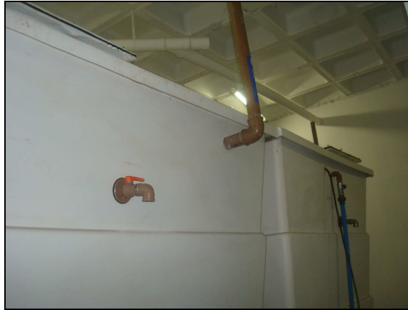
Figura 33: Torneira para coleta
