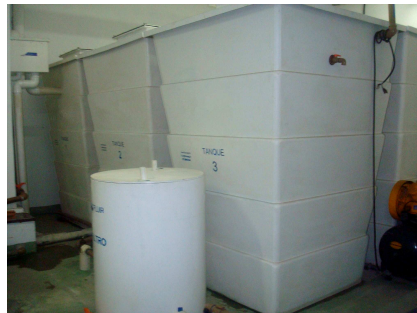
Figura 2: ETAC em escala real instalada na edificação
