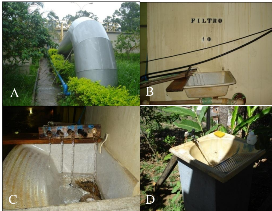
Figura 8. Pontos de coleta no Sistema Vale Esperança (A – Chegada de água bruta; B – Ponto de coleta dos filtros da ETA FD; C – Ponto de coleta dos filtros da ETA TC; D – Ponto de coleta do reservatório apoiado).
