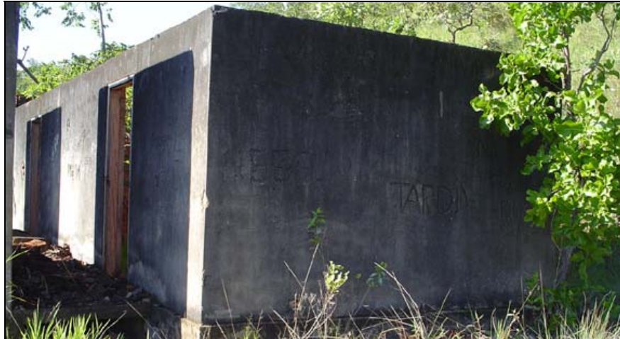
Figura 28 – ANTIGO DEPÓSITO DE INFLAMÁVEIS
