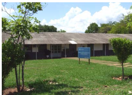
10. Escritório da Manutenção
