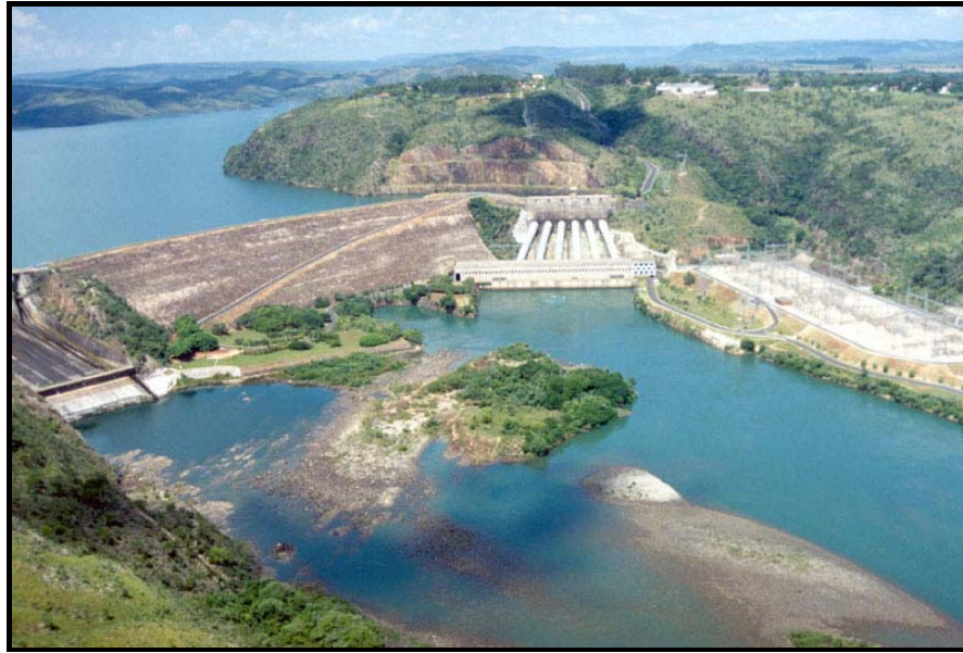
Figura 25. VISTA AÉREA DA USINA DE ESTREITO (LUIZ CARLOS BARRETO DE CARVALHO)
