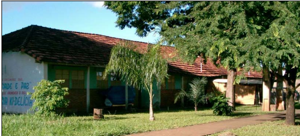
Figura 20 – RESIDÊNCIA GEMINADA NA VILA DE FRONTEIRA-MG
