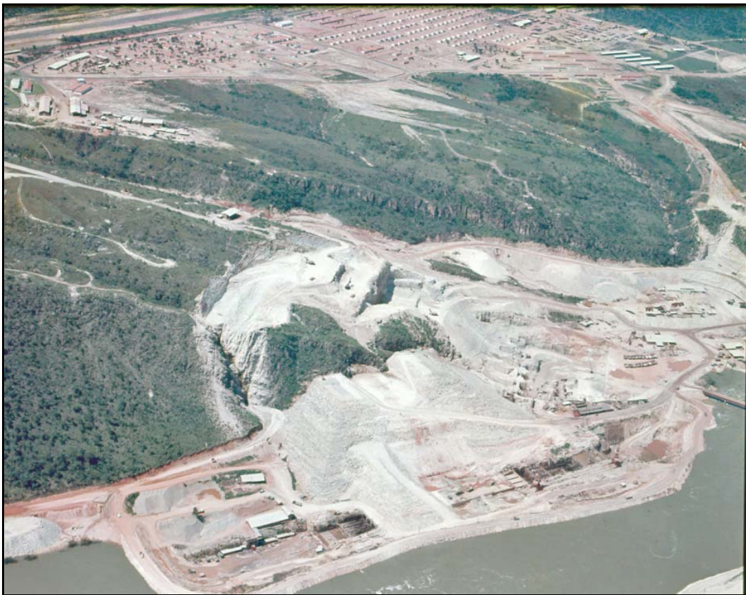
Figura 27 - VISTA AÉREA DA CONSTRUÇÃO DA USINA E DA CHAMADA VILA PROVISÓRIA – VILA DE ESTREITO-SP, 1967
