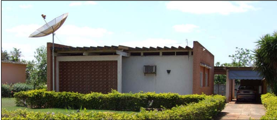
Figura 17 – HABITAÇÃO LOCALIZADA NA “MARGEM 1” – VILA DE PLANURA-MG, 2006
