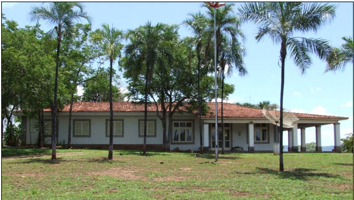
Figura 37 – CASA DE VISITAS – SETOR 1 – VILA DE ESTREITO-SP - 2007
