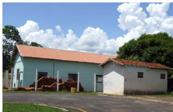
12. Estação de tratamento d'água
