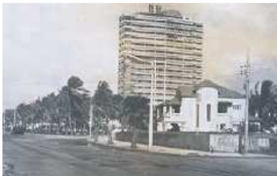
Figura 4.4 – Edifício Califórnia em 1959 construído no 2º Jardim de Boa Viagem.
