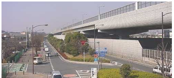
Figura 2.26 – Barreiras instaladas ao longo de via expressa elevada em área residencial de Tóquio, Japão. Fonte: CICHINELLI, 2007.
