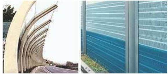
Figura 2.24 – À esquerda barreira acústica curva em concreto e acrílico na Suíça. À direita barreira acústica metálica na estrada entre Pádua e Veneza na Itália. Fonte: CICHINELLI, 2007.
