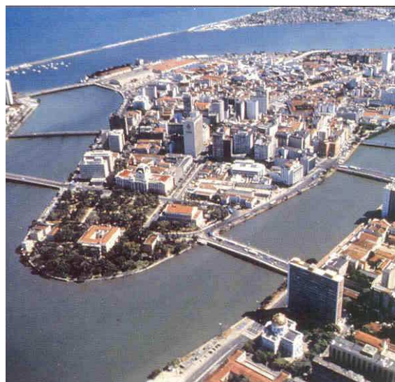
Figura 2.9 – O adensamento das ilhas do Bairro do Recife e de Santo Antônio (imagem) ocorreu tanto pelo preenchimento progressivo desde o início da ocupação da cidade, quanto por meio da demolição e substituição de edificações anteriores. Fonte: http://pedrodealbuquerque.wordpress.com/category/pernambuco/ . Acesso em: 20.11.09.
