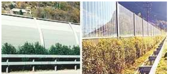
Figura 2.25 – À esquerda, barreira acústica metálica instalada próximo a Zurique. À direita barreira acústica em concreto e acrílico também na Suíça. Fonte: CICHINELLI, 2007.
