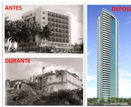
Figura 4.15 – Demolição do Hotel Boa Viagem e, em seu lugar, está sendo erguido o Ed. Maria Ângela Lucena, uma edificação multifamiliar de gabarito alto, com amplo número de unidades habitacionais e de pavimentos, mais um exemplar dos “arranha céus” residenciais de Boa Viagem.
