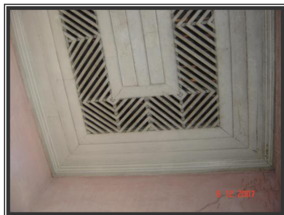
Imagem 27: Detalhe do forro – bordas e preenchimento em madeira. Fonte: Arquivo pessoal.
