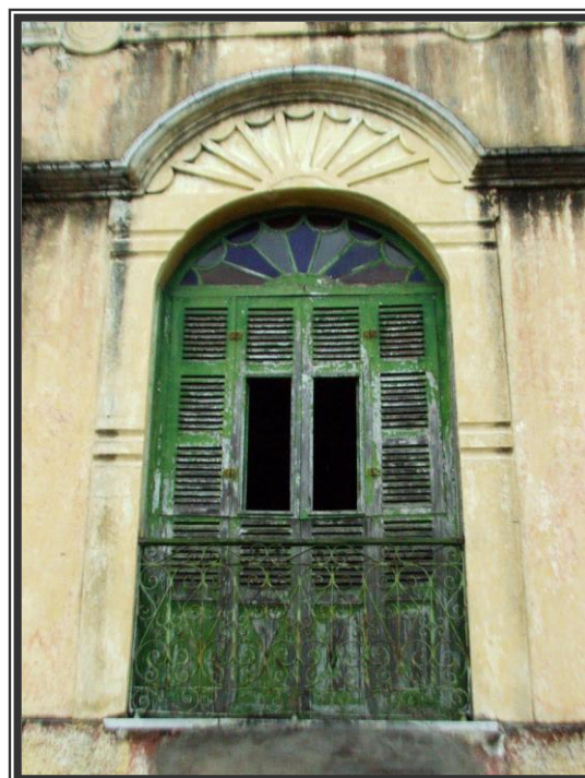
Imagem 21: Detalhe das esquadrias em madeira e do guarda-corpo originais. Fonte: Arquivo pessoal.
