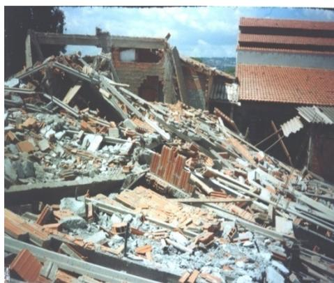
**Figura 1.04 – Desabamento total de uma obra residencial/comercial com três pavimentos, executada em Goiânia/2005. (Crea/GO)**
