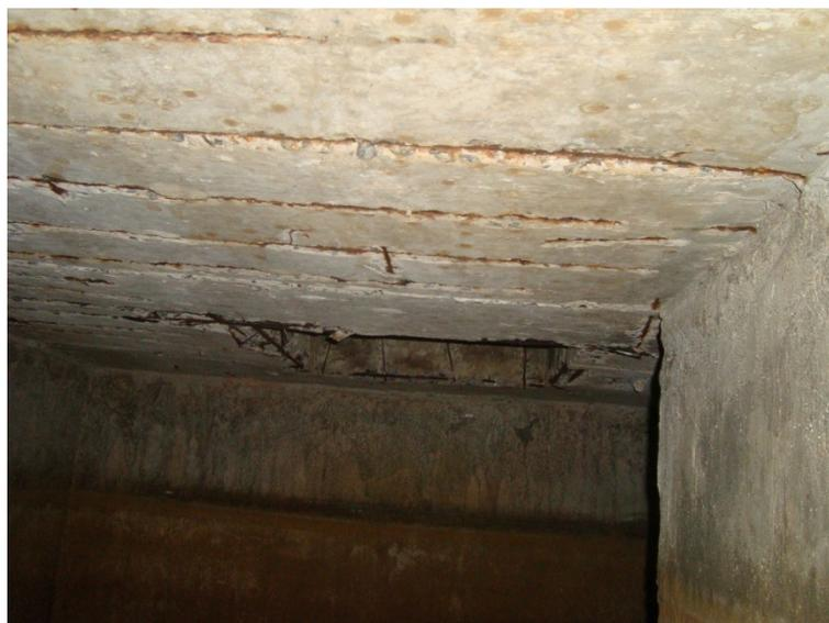
**Figura 3.12– Corrosão da armadura em laje. (Crea/GO)**
