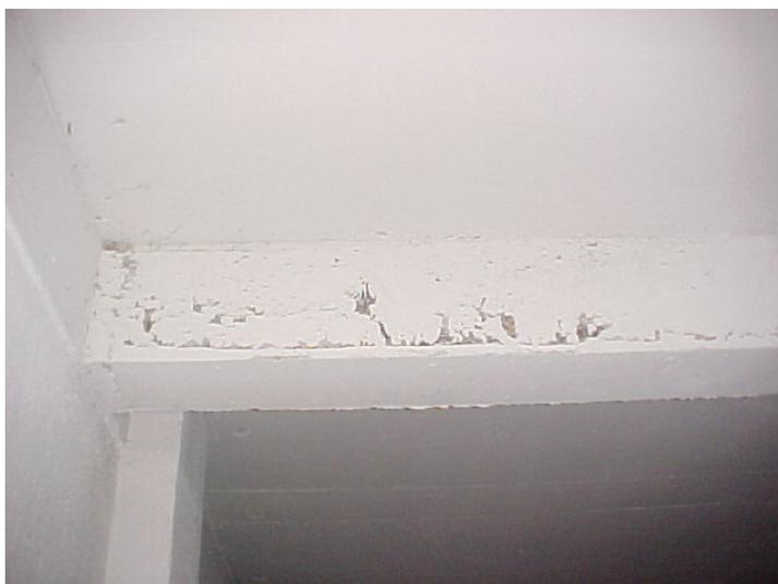
**Figura 3.19- Elementos em concreto armado com segregação.(Crea/GO)**
