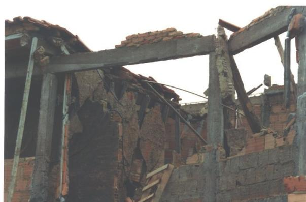
**Figura 1.02 – Desabamento parcial de um sobrado com estrutura de concreto armado. (Crea/GO)**
