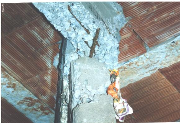
**Figura 1.01 – Pilar de imóvel residencial com falhas de concretagem e irregularidades geométricas, executada em Goiânia/1994.(Crea/GO)**
