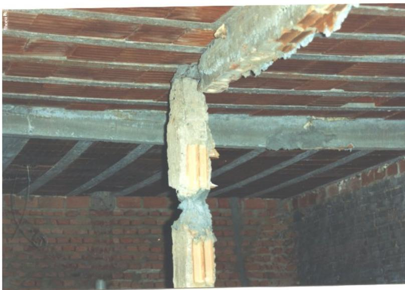
**Figura 3.17 – Viga e Pilar em concreto armado sem qualidade. (Crea/GO)**
