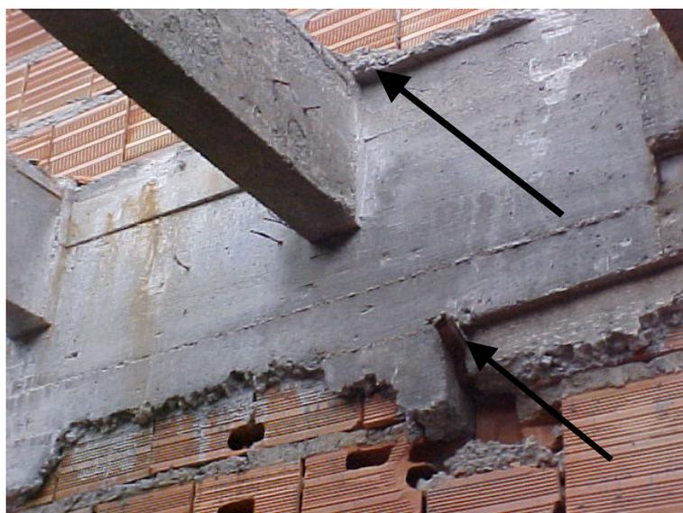
**Figura 3.18- Vigas em concreto armado com irregularidades geométricas. (Crea/GO)**
