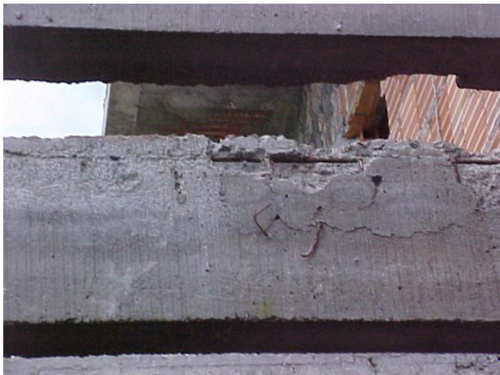
**Figura 3.16 - Vigas em concreto armado sem qualidade e espessura de cobrimento. (Crea/GO)**
