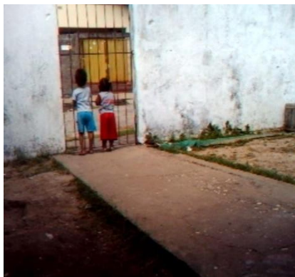
Figura 2 - Vista do Portão de acesso à escola
