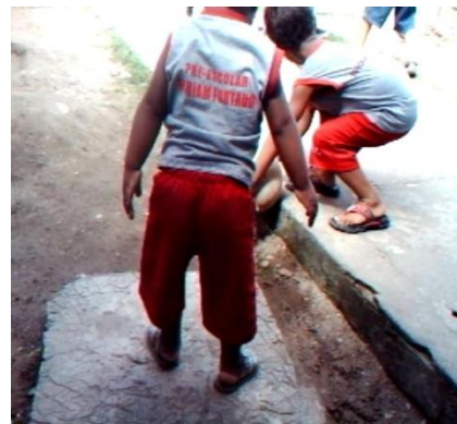
Figura 3 - Vista da fossa séptica
