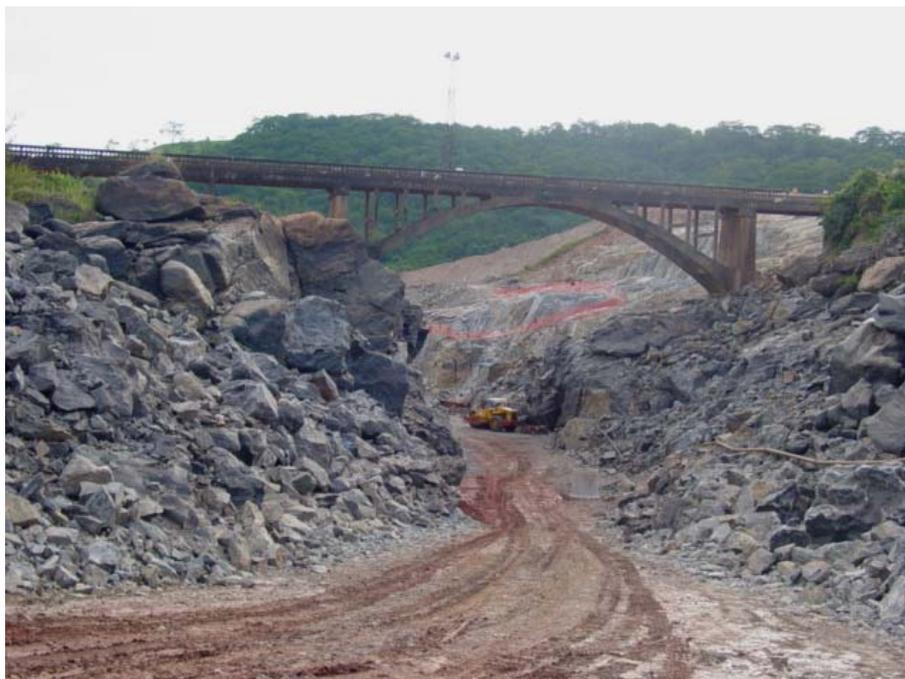
Figura 14. Ponte do Pau Furado após o desvio do rio Araguari para construção da UHE Capim Branco I, sendo aterrado o seu leito.
