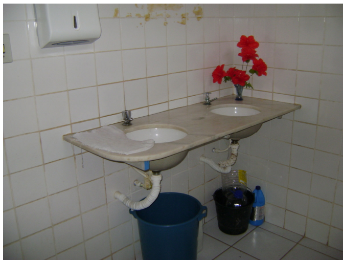
Foto 36: Imagem do sanitário feminino, 14/11/09
