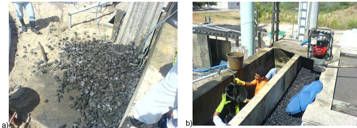
Figura 3.25: Limpeza dos filtros
