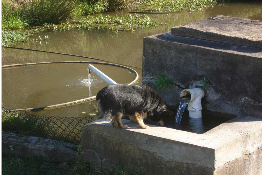
Figura 5 – Passagem da água por este ponto antes de ir para o local de coleta de água, e cano exposto a “céu” aberto, detalhe da figura cachorro bebendo água, no percurso antes de atingir o bebedouro/cano que deposita água para a comunidade (Acesso de animais em ponto intermediário antes da “bica d’água” no Bairro Santa Rosa Município de Porto União – SC). Fonte: Acervo do autor, (2009).
