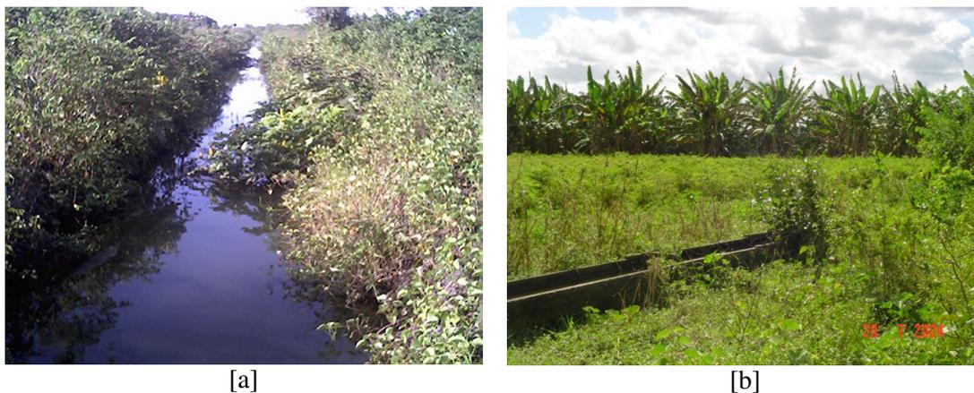
FIGURA 4 – [a] Vista interna do canal principal; [b] Situação do canal secundário, coberto pela vegetação – Perímetro Ayres de Souza, Ceará, 2004.
