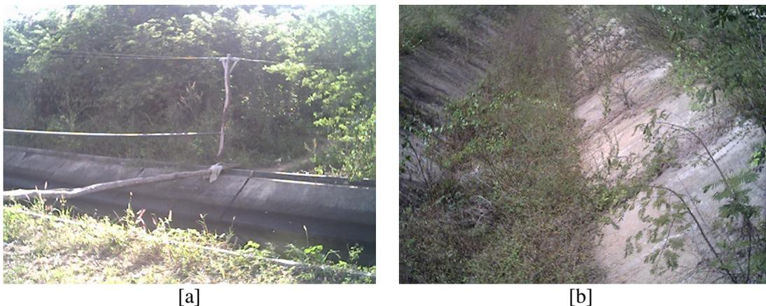
FIGURA 8 – [a] Passagem artesanal sobre o canal principal; [b] Vista interna do canal principal obstruído pela vegetação - Perímetro Irrigado Araras Norte, Ceará, 2004.
