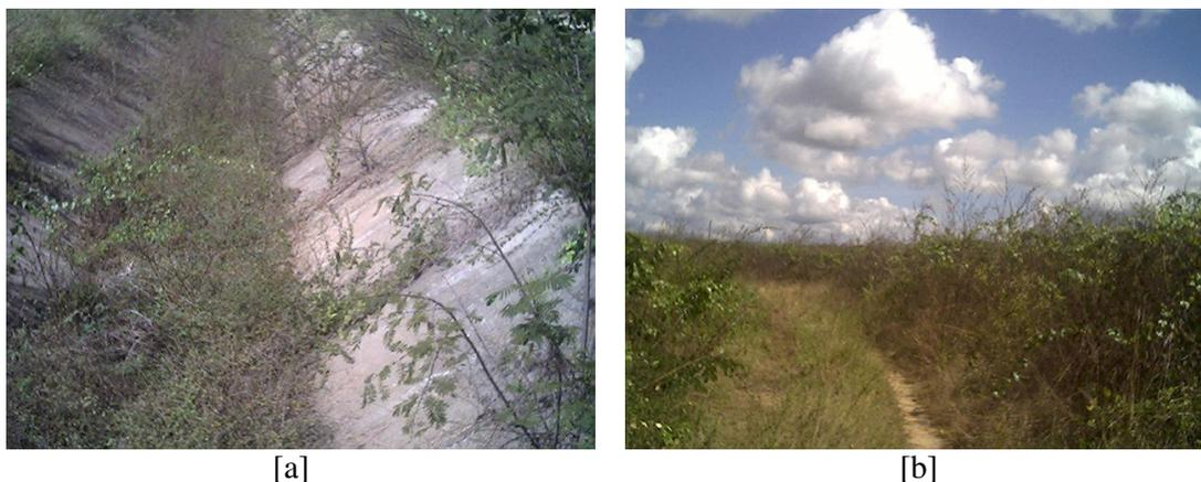
FIGURA 14 – [a] Vista interna do canal obstruído pela vegetação; [b] Estrada interna de acesso intransitável obstruída pela vegetação – Perímetro Irrigado Araras Norte, Ceará, 2004.
