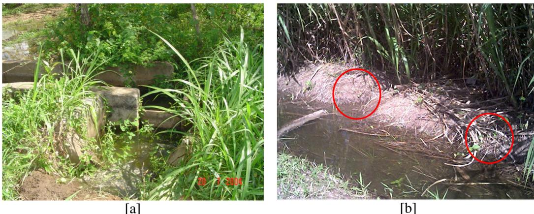
FIGURA 5 – [a] Situação do canal secundário - entrada para o lote com a cancela quebrada; [b] Cortes no canal parcelar - enfatizando o método de irrigação por sulcos, onde o canal é rompido no ponto inicial do terreno e fechado apenas após a inundação do sulco – Perímetro Ayres de Sousa, Ceará, 2004.
