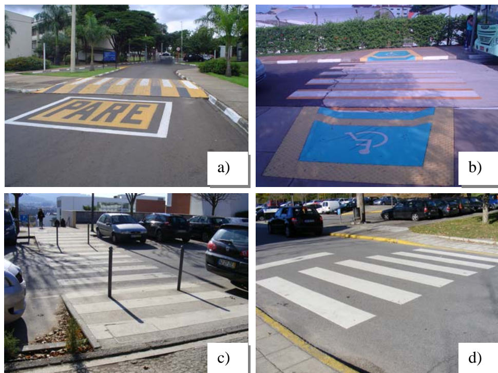
Figura 5.4: Exemplo de cruzamentos de vias de veículos com faixas de pedestres apropriadas no campus de São Carlos (a) e (b) e no campus de Gualtar (c) e (d)
