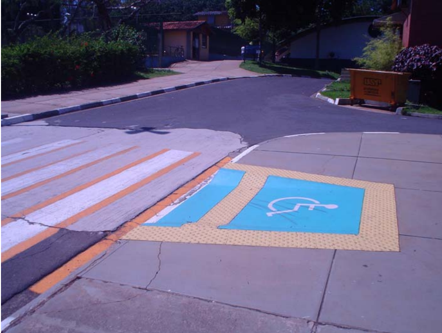
Figura 6.29: Travessia localizada no percurso selecionado para o teste de validação
