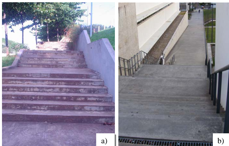
Figura 5.2: Exemplo de dois dos vários modelos de escadarias existentes no campus de São Carlos (a) e no campus de Gualtar (b)
