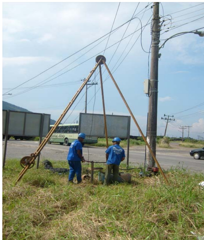
Figuras 21 e 22 – Equipamento de sondagem à percussão e equipe de sondagem abaixo.
