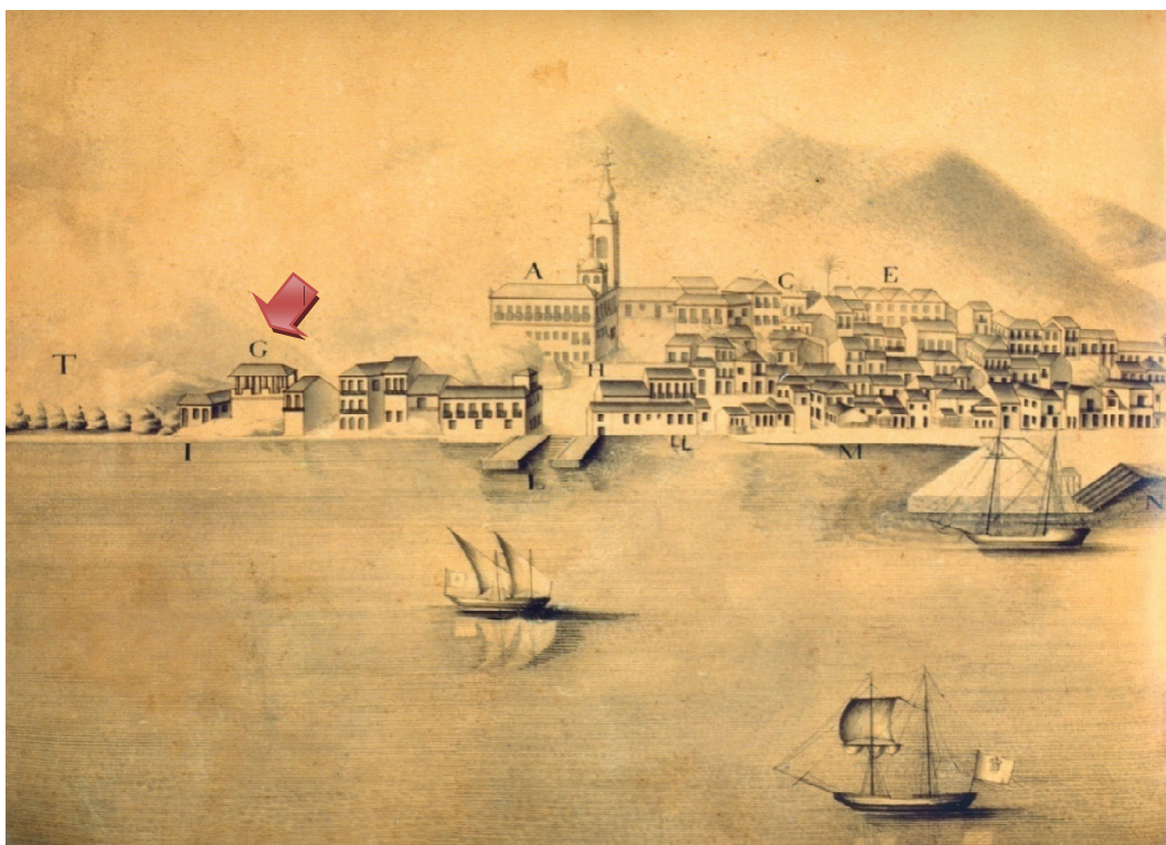
Figura - Detalhe da Perspectiva da Villa da Victória onde destacamos o Fortim de Santo Inácio ou São Maurício [letra G], de autoria de Joaquim Pantaleão Pereira da Silva, 1805. Fonte: Arquivo Histórico do Exército.
