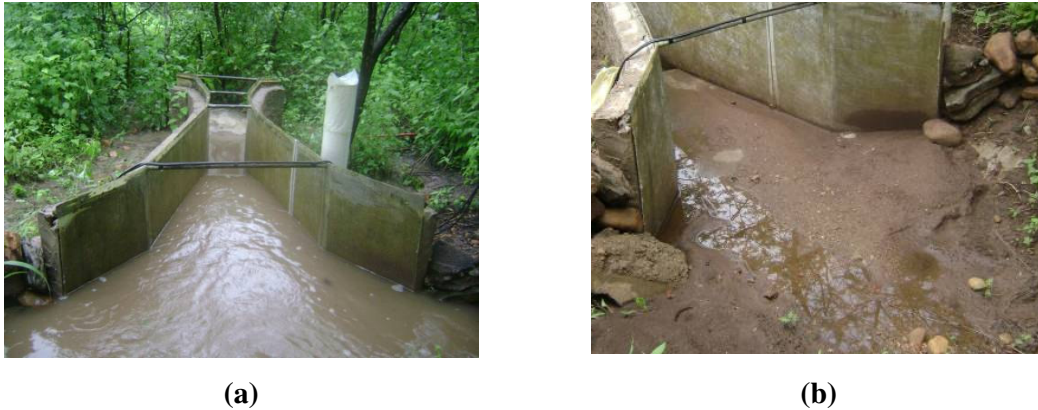
Figura 45 – Fluxo de água (a) e depósito de sedimentos próximo à calha Parshall da microbacia B3 (b).
