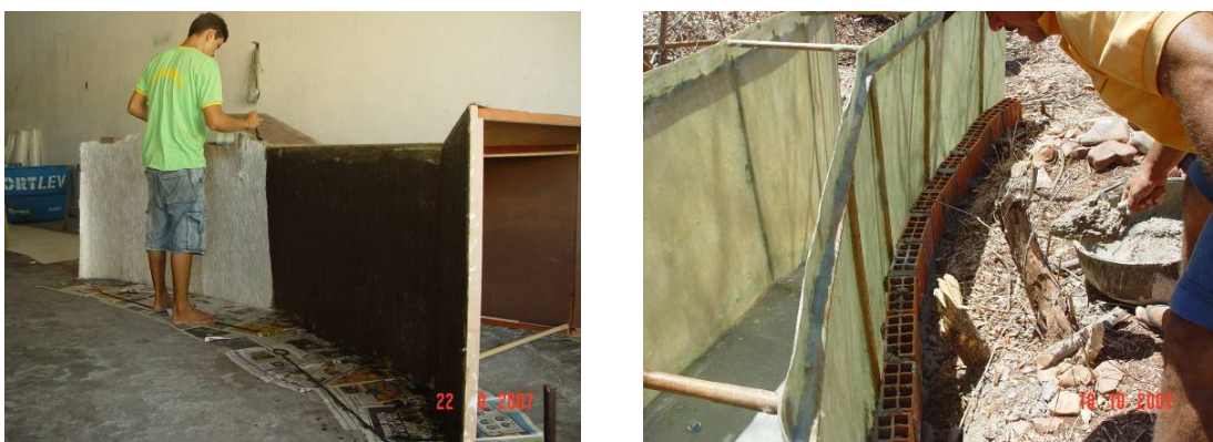
Figura 14 – Confeção das calhas Parshall em fibra de vidro [a] e instalação em campo com estrutura de alvenaria [b].
