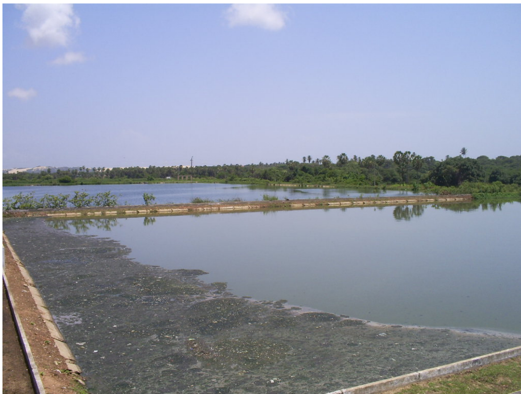
Figura 01. Lagoas anaeróbia e facultativa da ETE de Aquiraz, Ceará, 2008.
