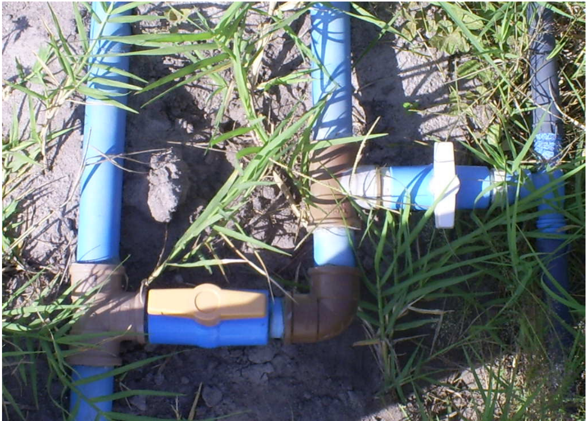
Figura 09. Visualização do registro que liga a linha de derivação da água do poço com a do esgoto tratado, Aquiraz – CE.
