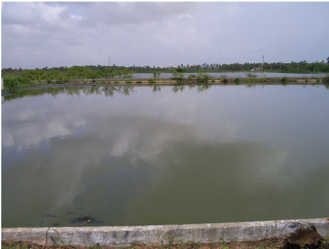
Figura 04. Lagoas de estabilização da ETE de Aquiraz, Ceará, 2008.
