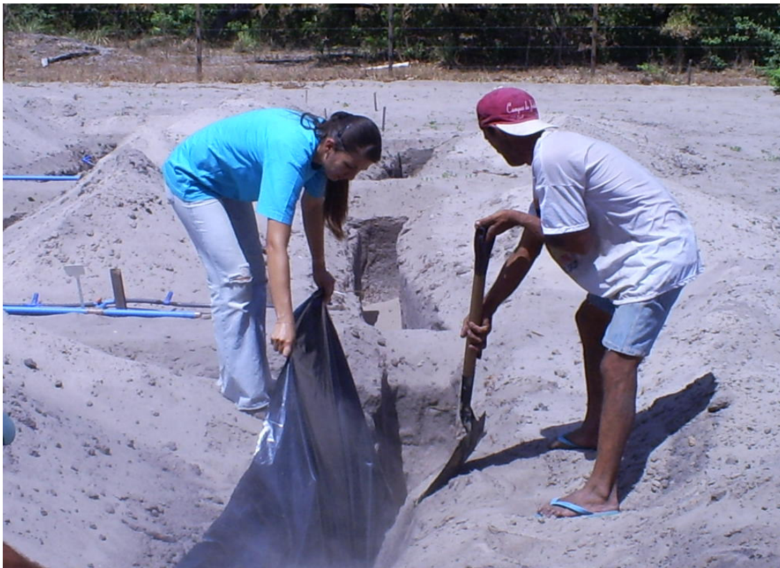
Figura 05. Instalação da manta preta de polietileno nas unidades de cada tratamento.
