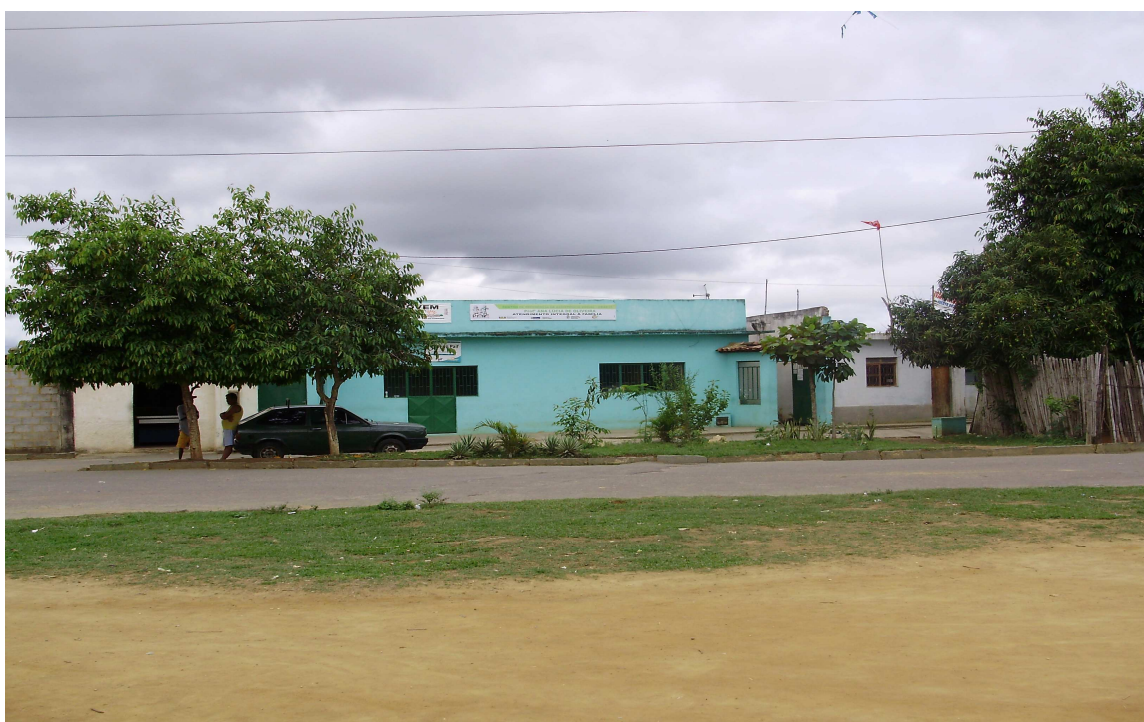
Foto 7: CRAS / SMAS – Instalado após a Implantação do PHB no CRHL . Nov. 2007 (à frente: espaço onde deveria existir a área de lazer)
