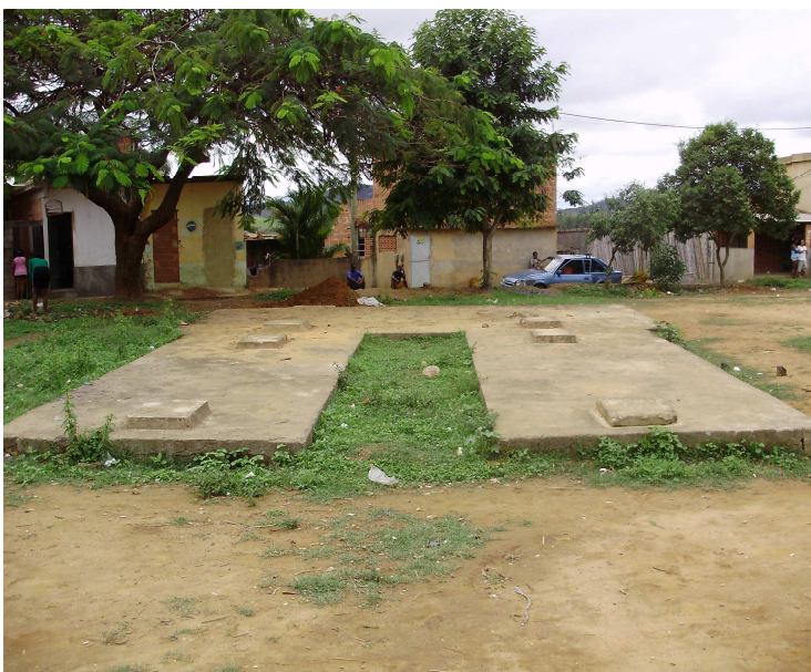
Foto 12: Fossa séptica construída ao lado das moradias do PHB – CRHL. Nov. 2007.
