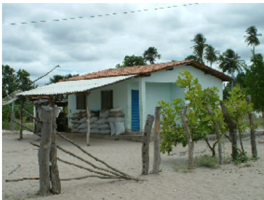
Casa Nova sendo usada como depósito de material. Foto: Simões, C.C.(2008)
