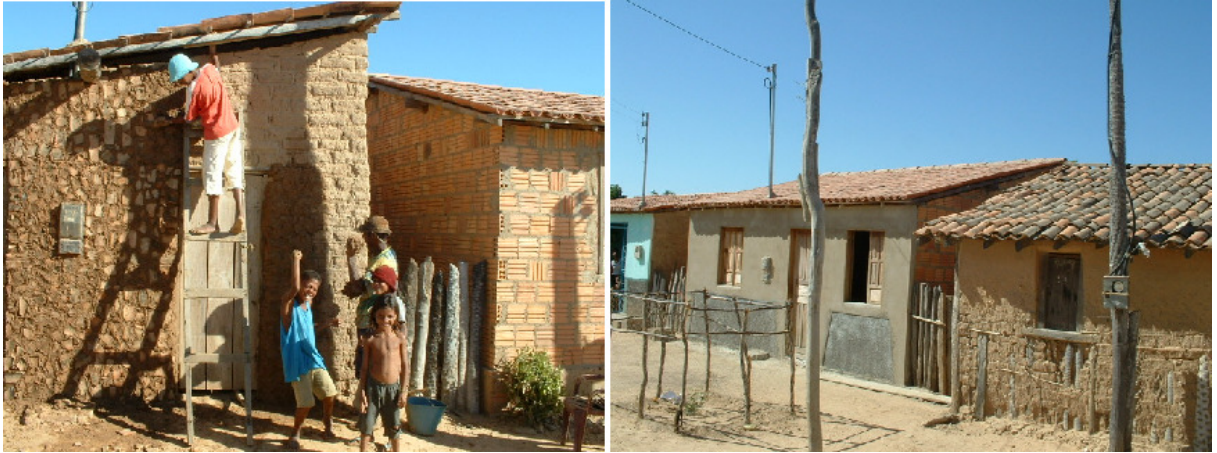
Fotografia 5 – Ampliação das Casas, Barra/Bahia Autor: C.C.Simões (agosto, 2007)
