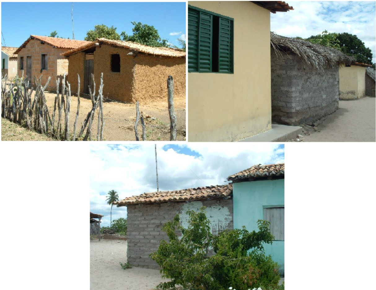
Fotografia 4 – Ampliação das Casas, Barra/Bahia Autor: C.C.Simões (agosto, 2007)
