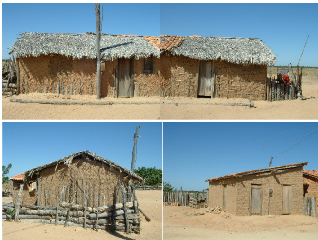
Tipologias Construtivas Locais. Foto: Simões, C.C.(2008)
