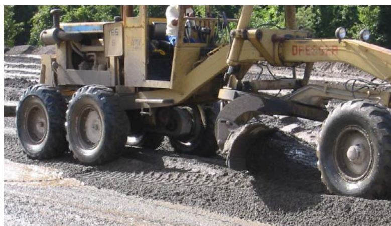
Figura 3.4 - Revolvimento da escória de aciaria LD do estudo durante o tratamento utilizado
