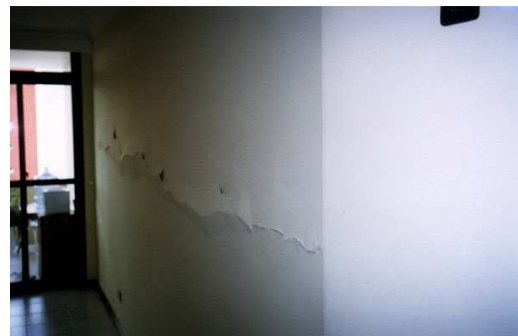
Deformação excessiva de lajes com rotação das vigas da borda
