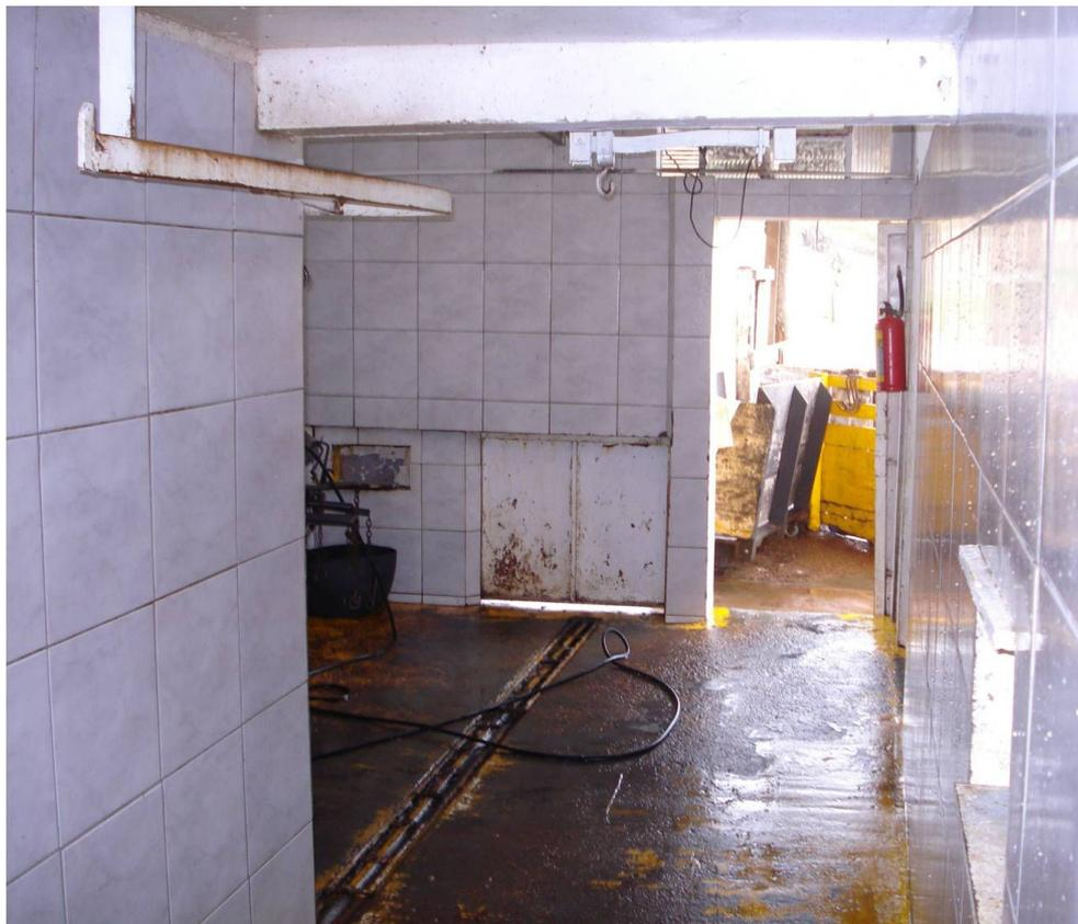
**Figura 12: Interior do Abatedouro Ovino: piso, canaleta e trilhos em mau estado de conservação**
