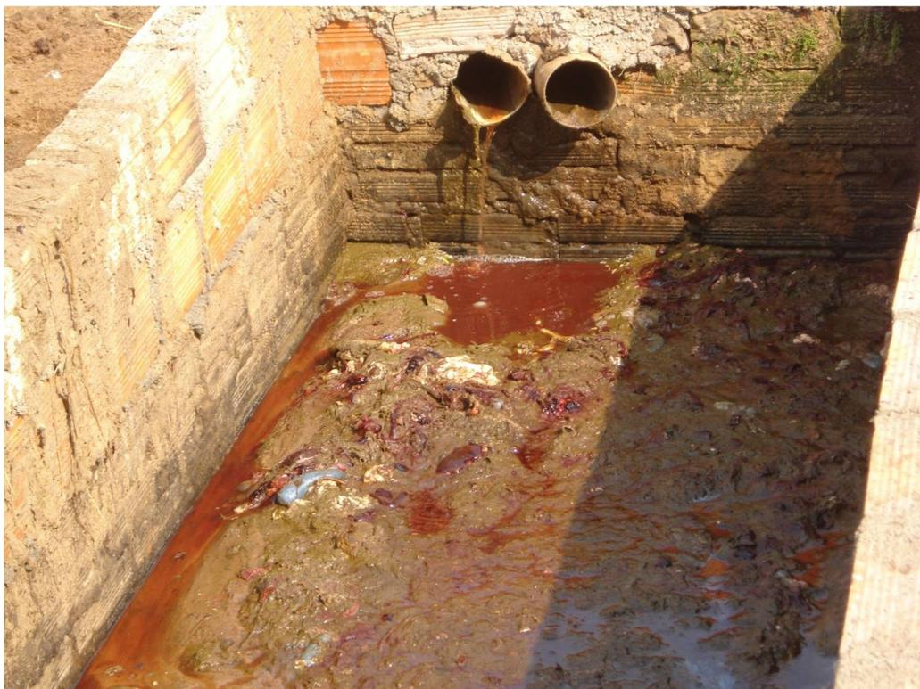
**Figura 8: Saída de dejetos do abatedouro ovino, com elevada carga de matéria orgânica, em grande parte constituída por conteúdo ruminal (mau manejo da carcaça).**
