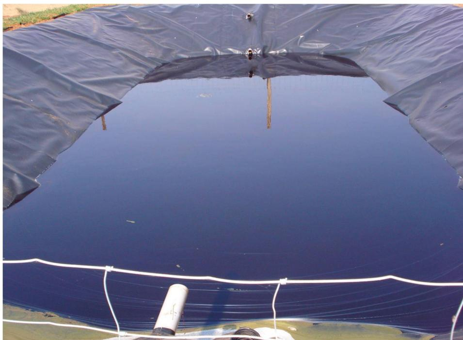
**Figura 9: Lagoa anaeróbia do abatedouro bovino, primeira de três lagoas, utilizada como tentativa de diminuir a carga poluidora proveniente do abatedouro.**
