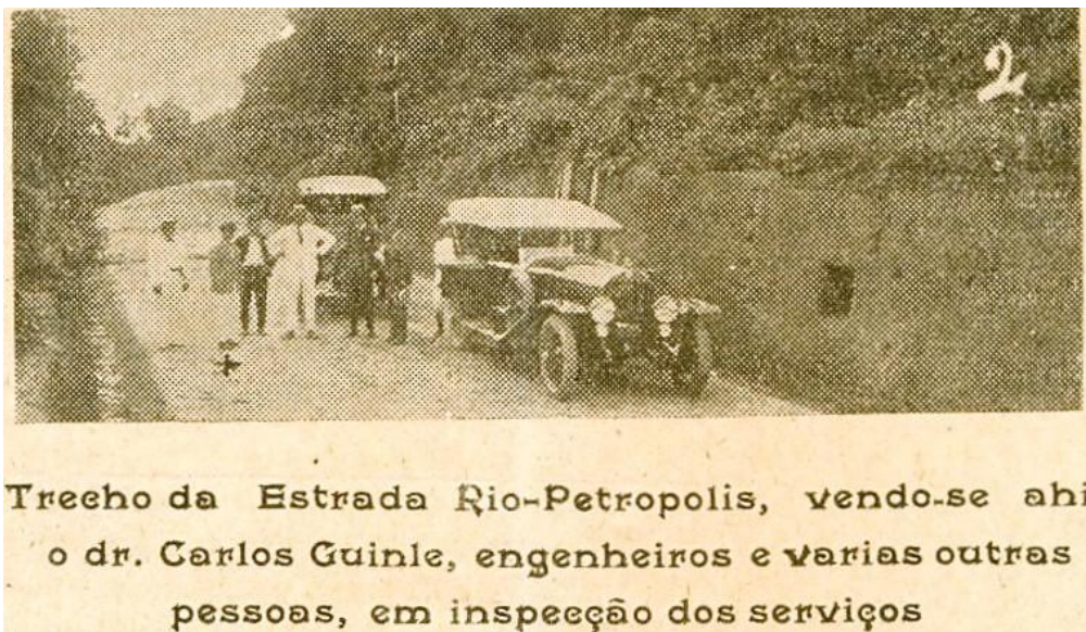
Figura 27: Obras da Rodovia Rio-Petrópolis Fonte: Petropolis-Turismo (1924,s/p).
