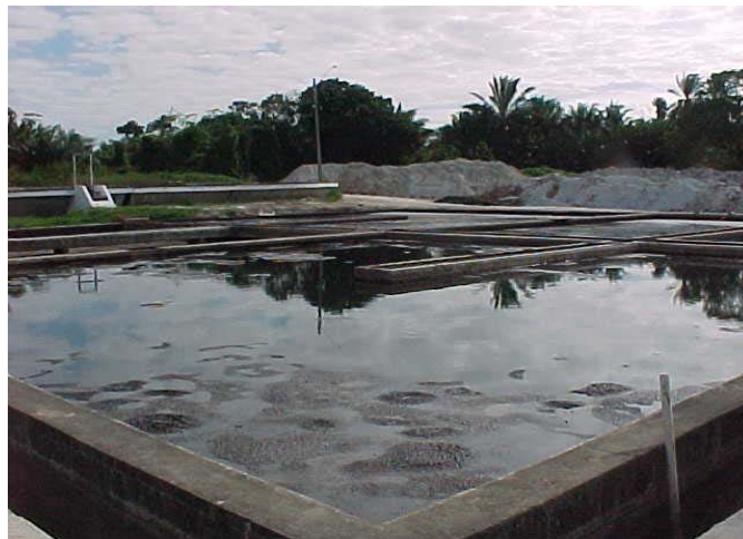
Figura 2.3 – Leito de secagem – Estação de Tratamento de Esgotos – ETE Curado.
