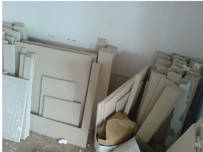
Figura 4.24 trinchos de cerâmica separados para reaproveitamento
