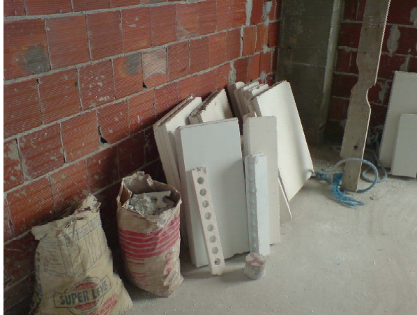
Figura 4.19 Triagem de resíduos de Gesso
