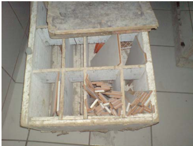
Figura 4.13 Triagem para reutilização de cerâmica na obra
