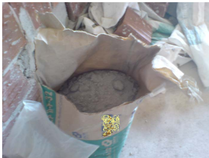
Figura 4.34 acondicionamento de resíduos em saco
