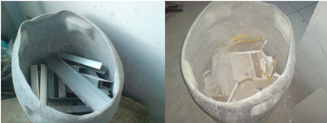
Figura 4.14 Triagem de resíduos de metal e gesso
