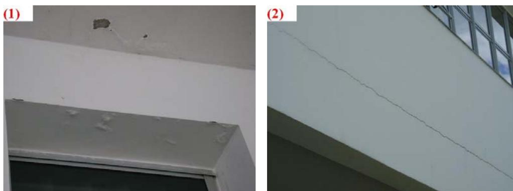
Figura 4.2 - Patologias identificadas no prédio “B” - (1) início da desagregação do revestimento devido à pulverulência; (2) fissura horizontal na interface da viga com alvenaria.
