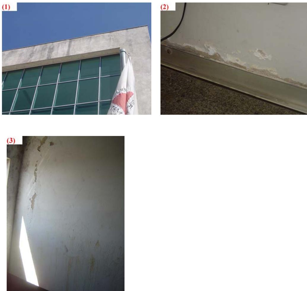
Figura 4.11 - Patologias identificadas no prédio “K” - (1) formação de bolor; (2) descolamento com pulverulência; (3) eflorescência.
