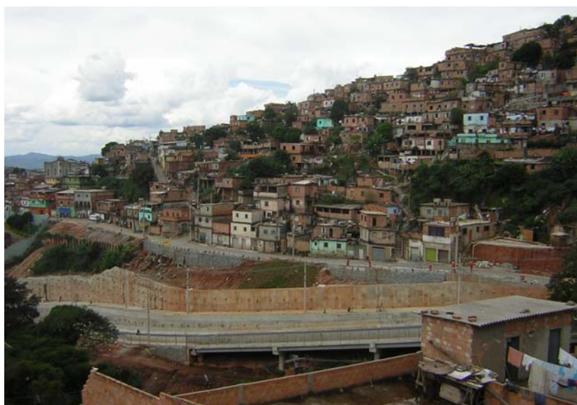
Figura 3.24: Vista da Av. do Cardoso, na Vila Nossa Senhora de Fátima Fonte: acervo próprio
