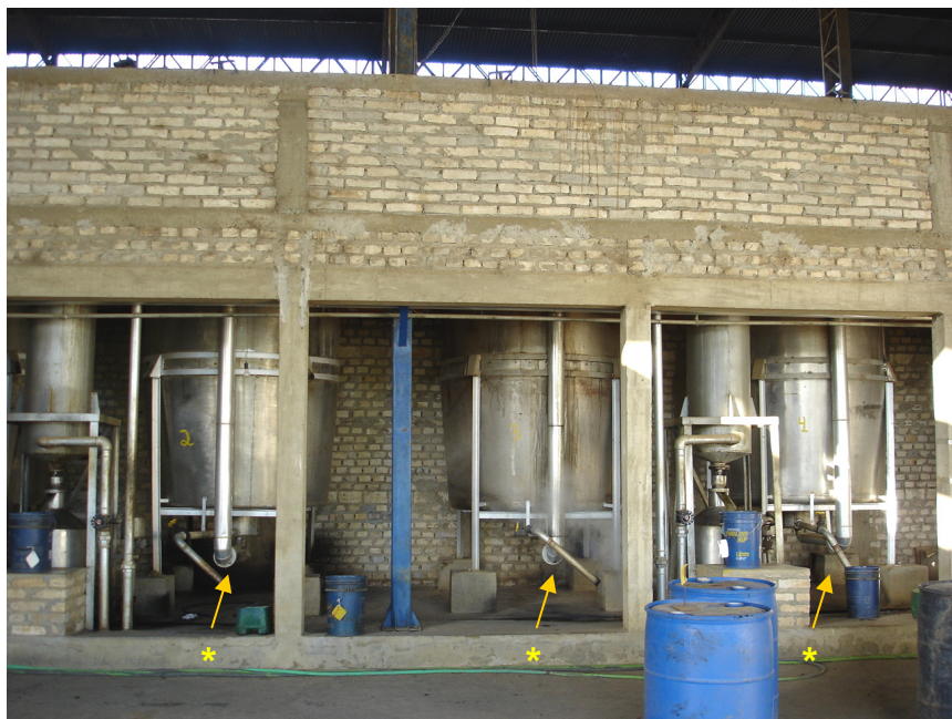
Figura 15 - Dornas utilizadas na produção de óleo essencial * Locais de remoção do resíduo efluente
