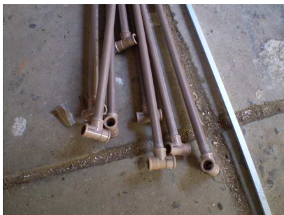
Figura 3.1. União entre tubos e conexões de PVC.
