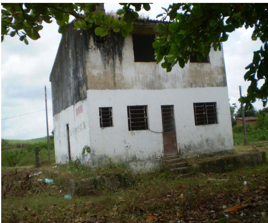
Prédio em que Edna Oliveira pretende instalar um centro cultural na Vila dos Palmares
