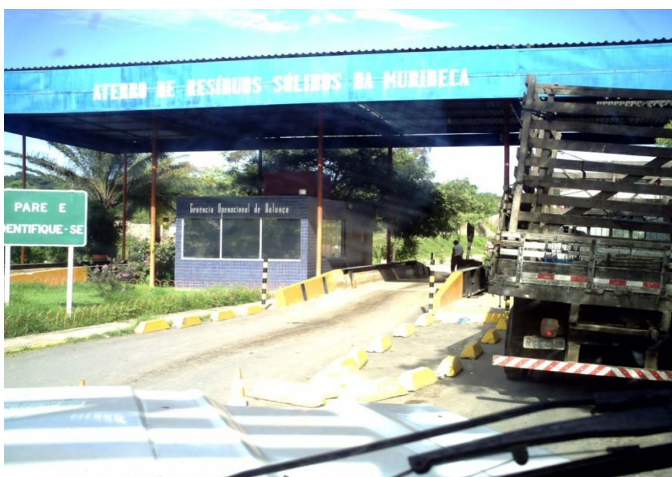
Entrada principal do Aterro de Resíduos Sólidos da Muribeca
