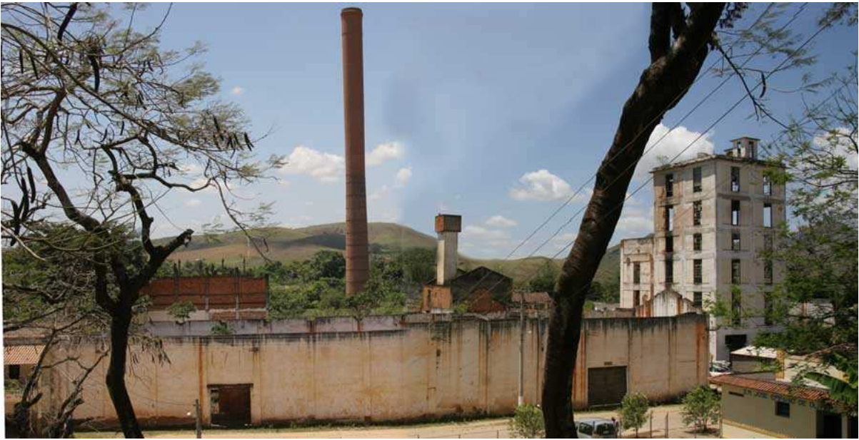
Fogos Mortos – Fotografias das ruínas de três usinas no Norte Fluminense. Na ordem em que aparecem: Cambaíba, em Campos dos Goytacazes e Santa Isabel e Santa Maria, em Bom Jesus do Itabapoana. (Fotografadas em 03/12/2005).
