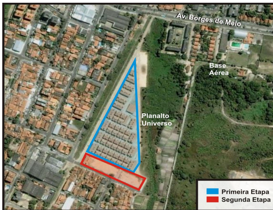
Figura 12. Planta aérea do CRPU (imagem apresenta a segunda etapa, em construção).
