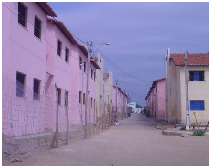
Figura 20. À esquerda os blocos da Maravilha, em construção, ao lado dos antigos blocos do CRPU, à direita. Foto: Ano 2007.
