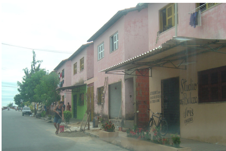
Figura 22. CRPU - Blocos de apartamentos localizados na avenida 13 de Abril.
