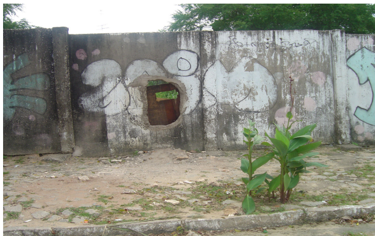
Figura 17. Muro da RFFSA que limita CRPU e entorno.
