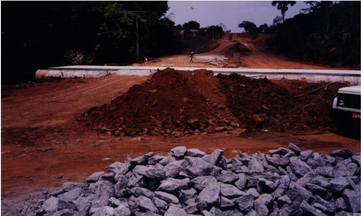
Figura 2 – Vista parcial da Av. Nadra Bufaiçal no Setor Faiçalville em processo de elevação e duplicação para ser pavimentada.
