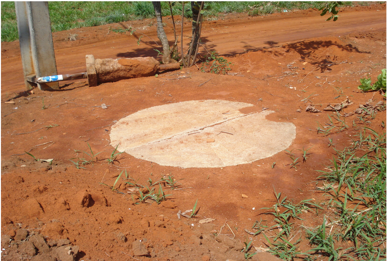
Figura 15 - Fossa e rua sem pavimentação asfáltica – Setor Faiçalville. Fonte: Acervo pertencente ao autor (Edival F. Mendes) – Nov. 2008.
