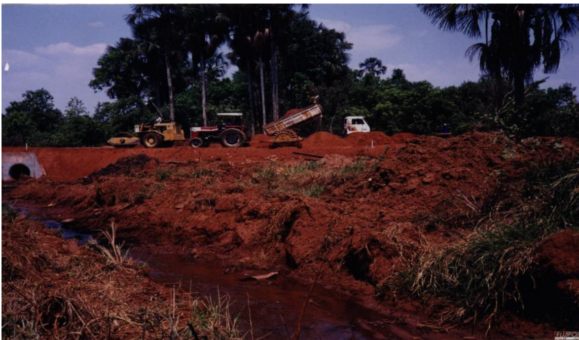
Figura 3 – Vista parcial da Av. Madri no Setor Faiçalville em processo de elevação e duplicação para ser pavimentada.
