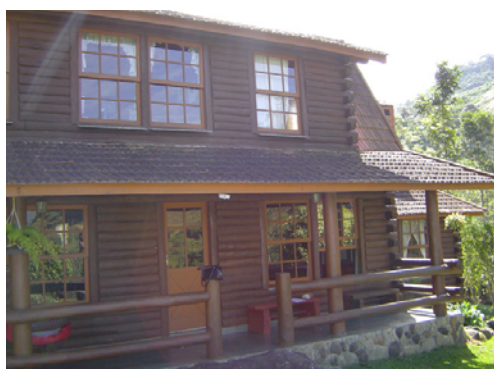
Figura 35 – Residência em Piaçu, no sistema construtivo log home , 1997.
