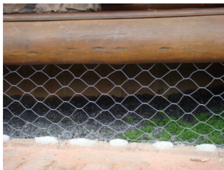
Figura 57 - Apoio da edificação sobre blocos de concreto.
