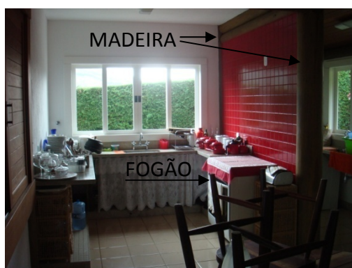
Figura 81 – Presença da madeira na estrutura da cozinha.
