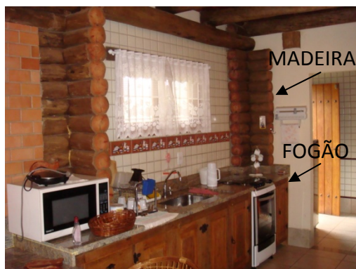
Figura 69 – Cozinha em contato direto com peças de madeira.
