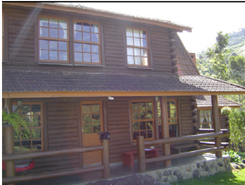
Figura 4 - Residência em Piaçu, no sistema construtivo log home , 1997.
