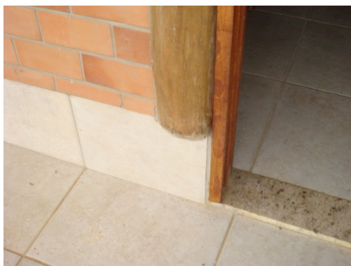
Figura 67 – Madeiramento afastado do piso.
