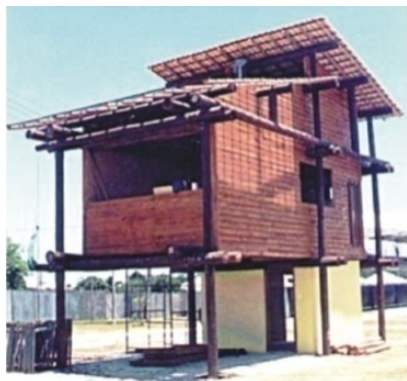
Figura 37 - Habitação no sistema pilar/viga. Fonte: Cunha (2004, p. 4).
