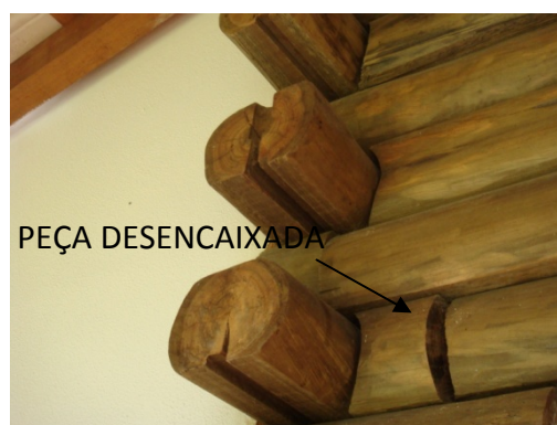
Figura 71 - Peça desencaixada.
