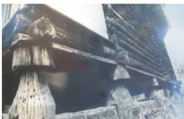
Figura 19 – Detalhe da elevação do solo - Arquitetura primitiva chinesa. Fonte: Estuqui Filho (2006, p. 30).
