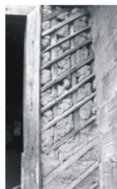
Figura 30- Detalhe da trama utilizada na técnica taipa de mão no Espírito Santo.
