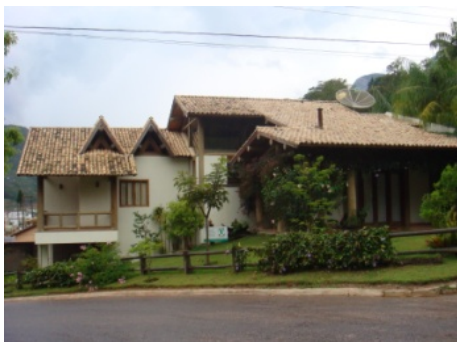
Figura 8 – Residência com o sistema construtivo pilar e viga, Pedra Azul, 2002.
