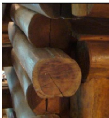
Figura 49 – Peças encaixadas formando a parede em log home .
