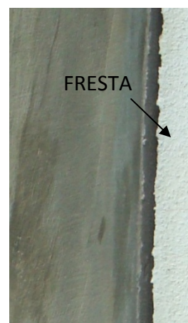
Figura 77 - Detalhe de fresta na parede externa.
