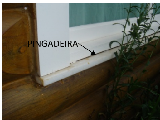
Figura 89 – Pingadeira da janela.
