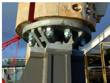
Figura 23 - Detalhe de fixação dos pilares de madeira na estrutura metálica.
