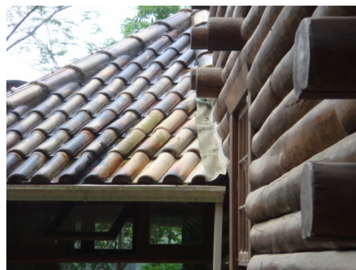
Figura 55 – Cobertura com o rufo e calha.
