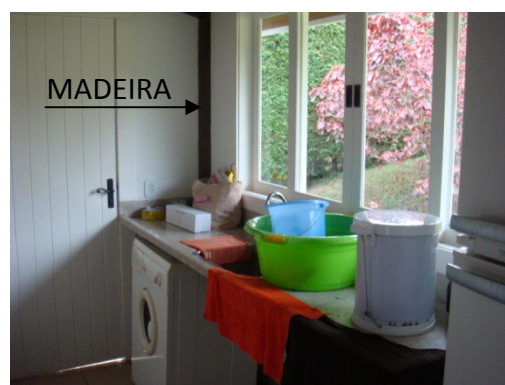
Figura 82 – Área de serviço com estrutura em madeira.
