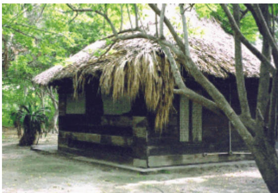
Figura 45 – Exemplos de construção no sistema construtivo semi pré-cortado.
