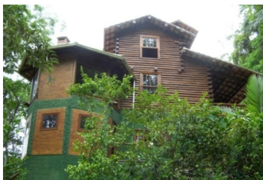
Figura 12 – Residência no sistema construtivo log home e convencional, no município de Domingos Martins, 2003.
