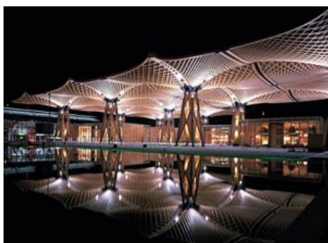
Figura 22 – Vista Expodach, arquiteto Thomas Herzog, Hanover, Alemanha.
