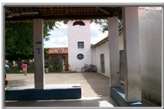
Foto 01: Fachada lateral do CMEI-Sul I Fonte: Acervo pessoal da pesquisadora
