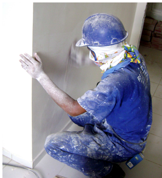
Figura 16 B – Lixamento de parede
