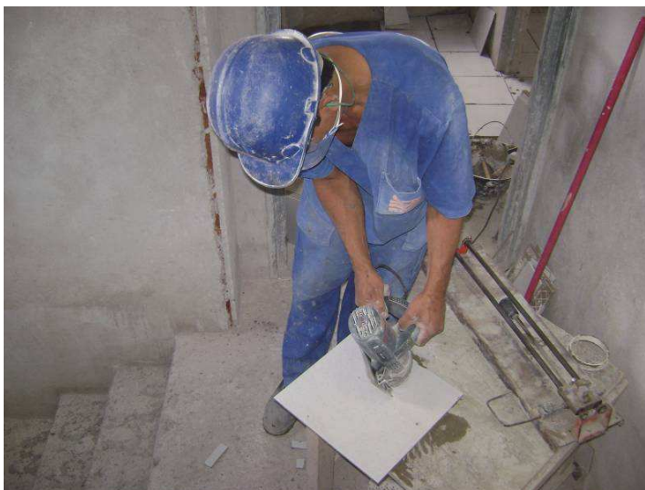
Figura 8 – Corte de cerâmica
