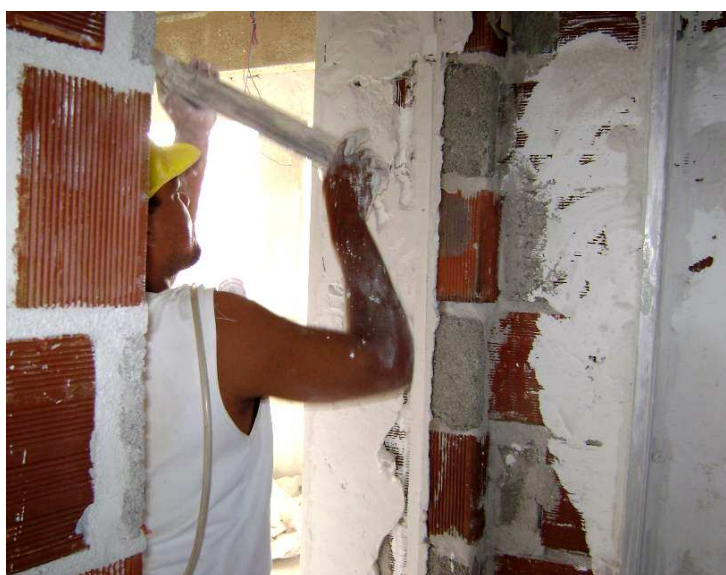
Figura 15 – Aplicação da pasta de gesso
