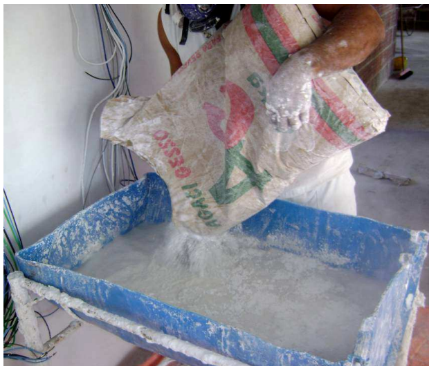
Figura 13 – Preparação da pasta de gesso
