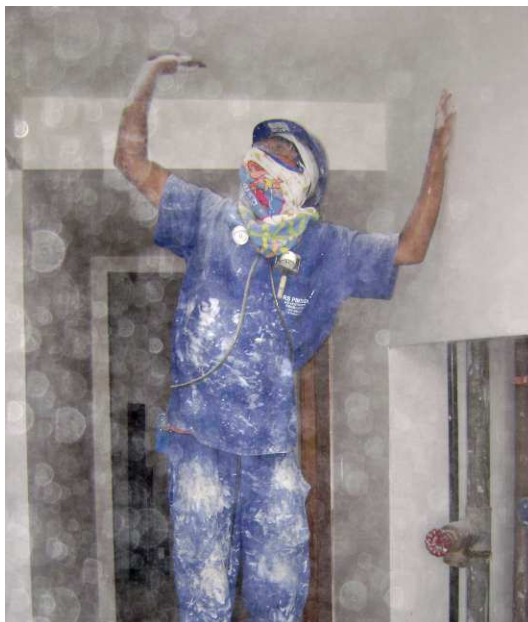
Figura 17 – Lixamento no teto
