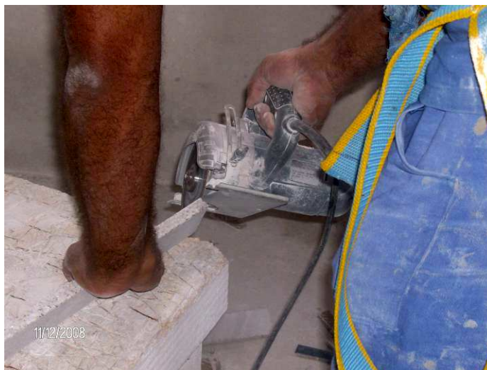
Figura 9 – Corte de granito
