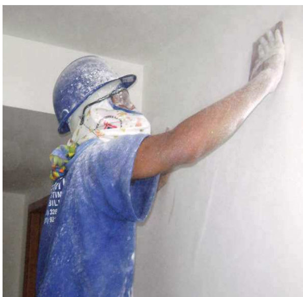
Figura 16 A – Lixamento de parede
