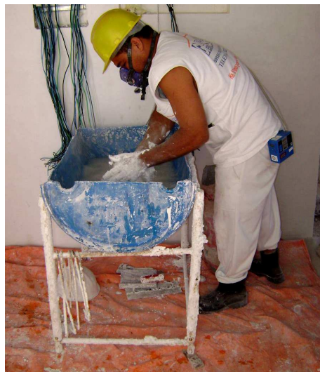
Figura 14 – Gesseiro misturando a pasta de gesso
