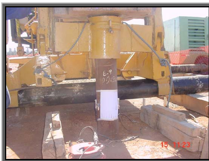
Figura 4.5 Sensores instalados e etiqueta para registro de nega e repique
