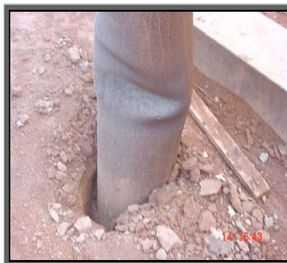
Figura 4.9 Flambagem local do trecho livre da estaca E07
