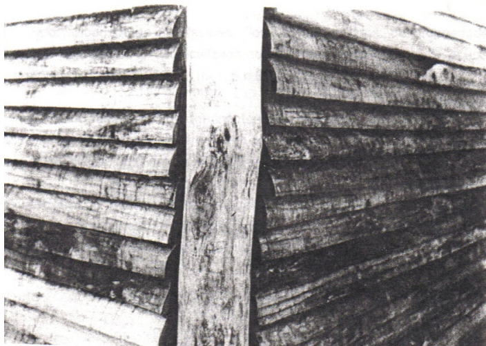
Figura 1. 4: Detalhe do sistema de vedação externa do protótipo ¼ de log Fonte: ROCHA (1994)
