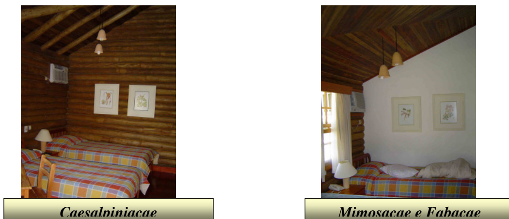
Figura 5. 16: Substituição da vedação interna dos apartamentos
