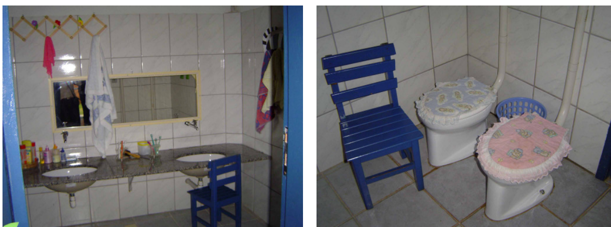
Figura 5. 12: Banheiro da sala de aula da creche adaptado para crianças
