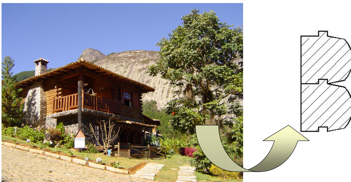
Figura 5. 6: Vista geral do chalé Peterly`s e detalhe dos encaixes das toras
