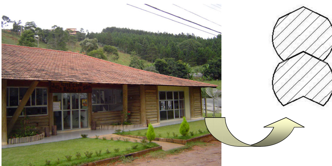
Figura 5. 10: Vista frontal da creche de Pedra Azul e detalhe do encaixe das toras
