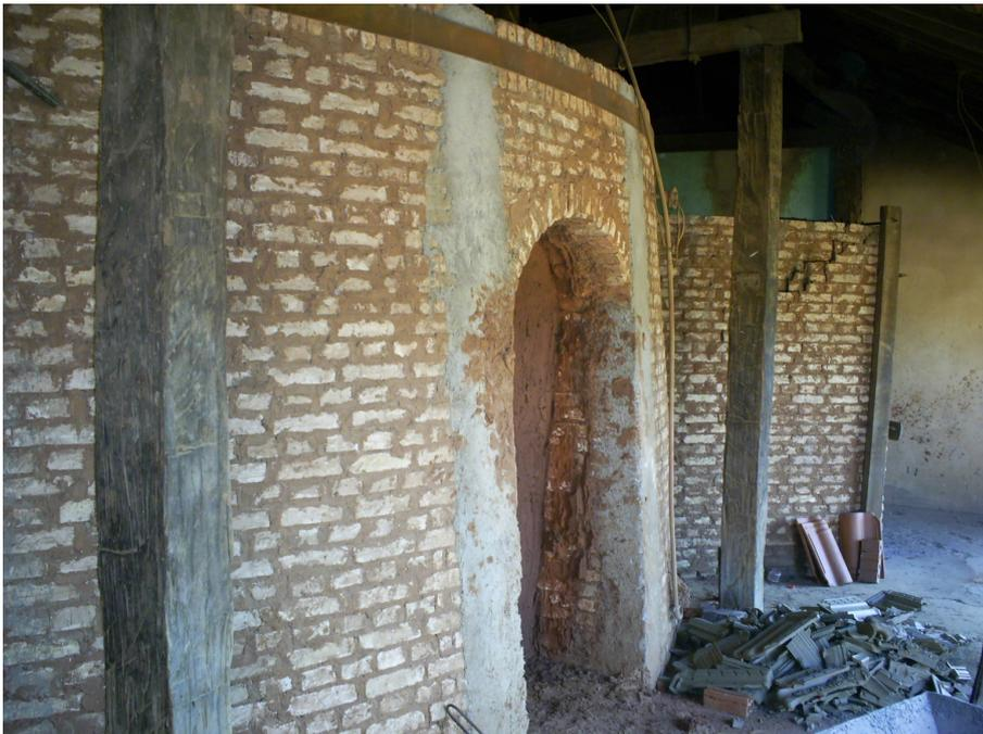
Figura 53: Entrada lateral do Forno Abóbada para inserção das peças para queima.
