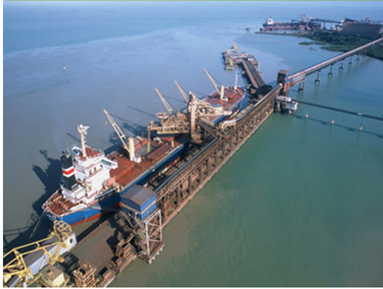
Figura 1.2: Terminal Marítimo da Ponta da Madeira - Vale. Fonte: [VALE, 2008]
